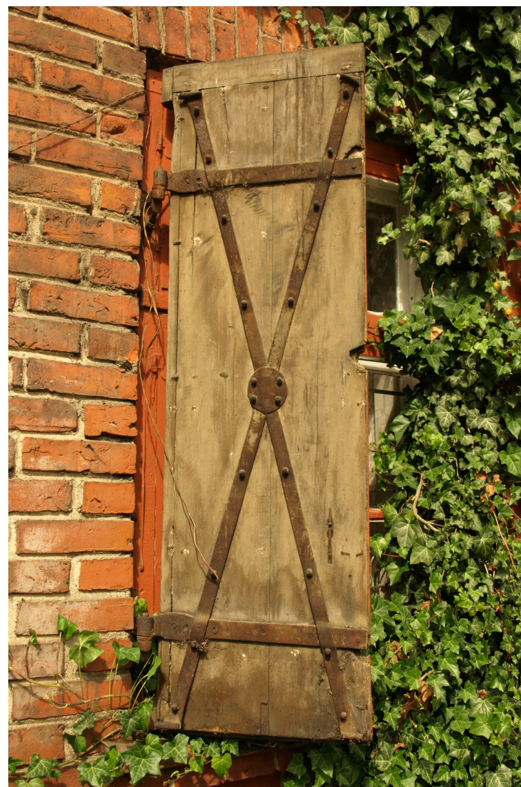
Rainja_2_62010230004001_slegi2 Sākotnējs (20.gs.sāk.) slēģis ar oriģinālo aprīkojumu.
