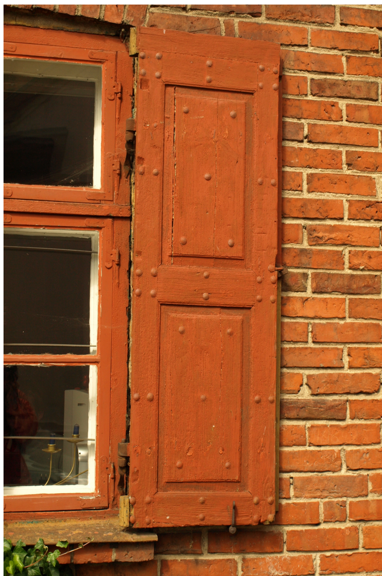
Rainja_2_62010230004001_slegi1 Sākotnējs (20.gs.sāk.) slēģis ar oriģinālo aprīkojumu.
