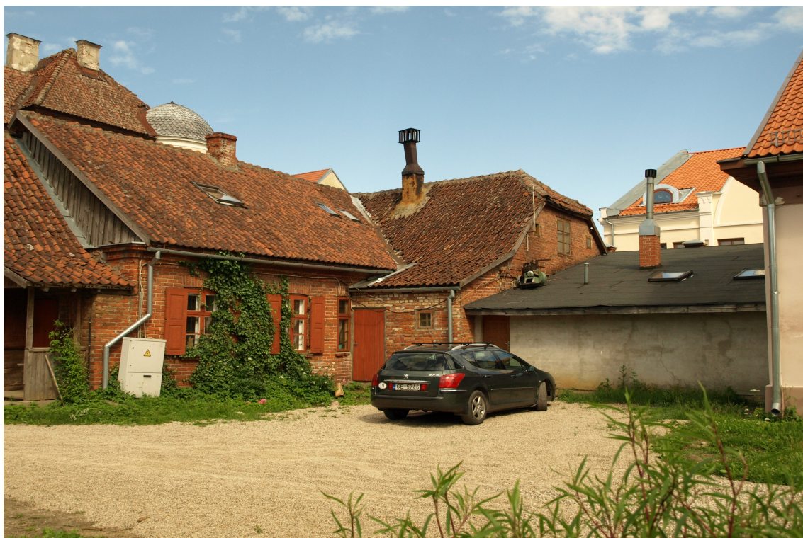
Rainja_2_62010230004001_fasade4 Skats uz ēku no dienvidaustrumiem.
