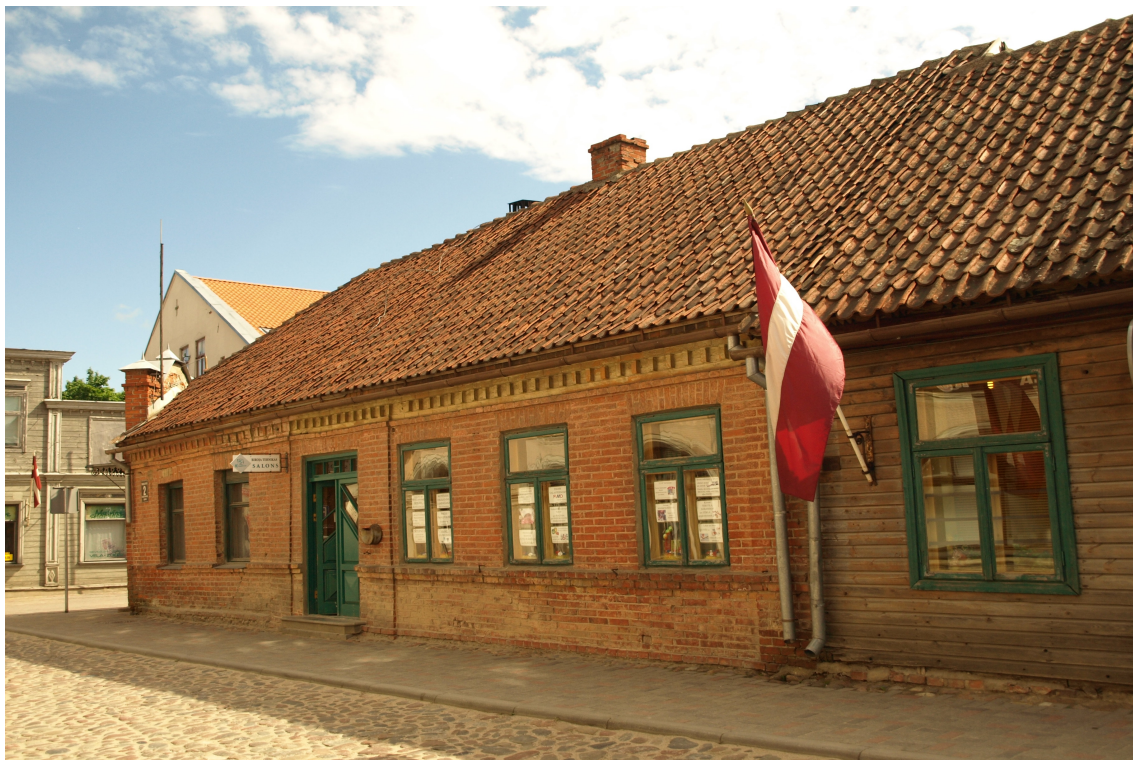
Rainja_2_62010230004001_fasade3 Skats uz ēku no dienvidrietumiem.
