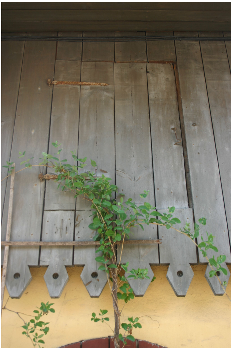
Polijas_13_62010060048002_fragments1 20.gs.2.puses drempeļa apšuvums un durvis. Durvīm izmantotas vecākas viras.
