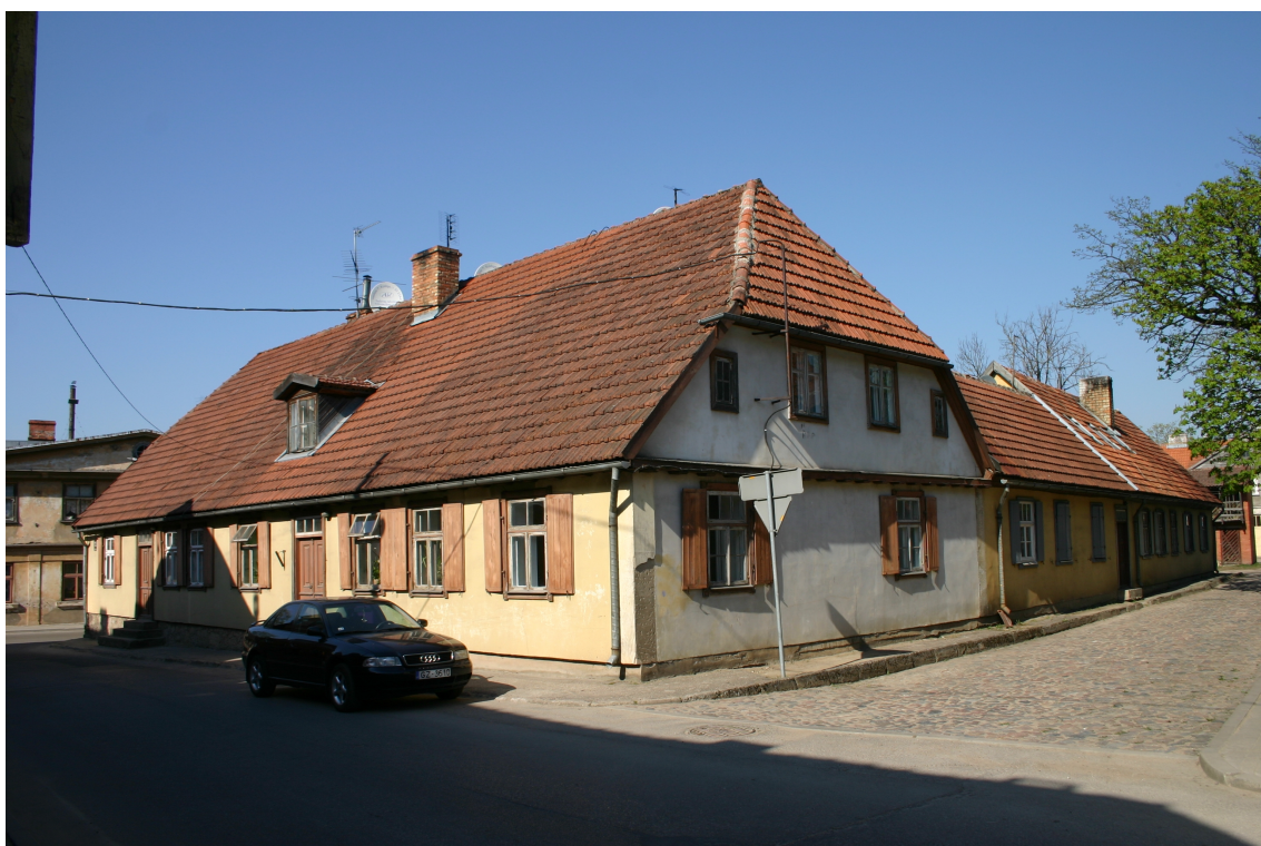
Policijas_13_62010060048001_fasade2 Skats uz ēku no dienvidrietumiem.
