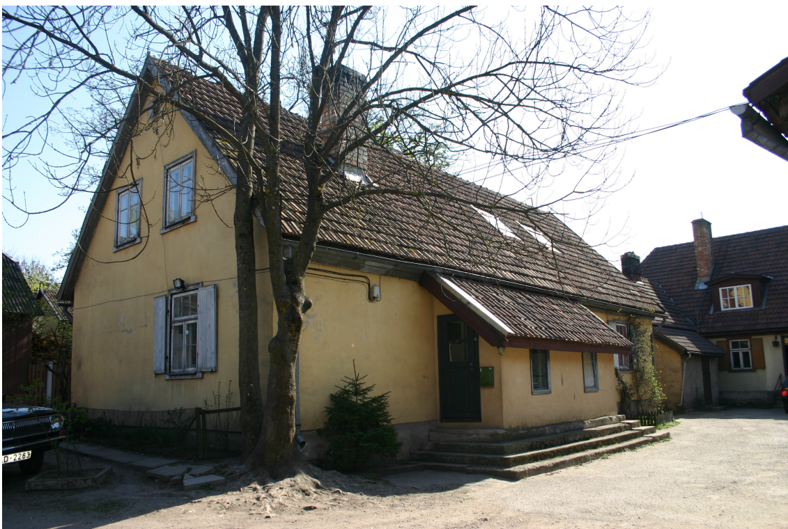
Policijas_13_62010060048001_fasade4 Skats uz Šķērsielas korpusu no ziemeļaustrumiem.
