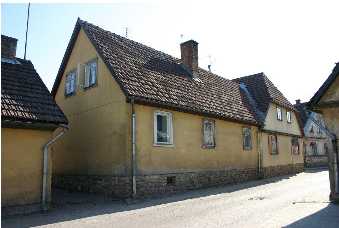
Policijas_13_62010060048001_fasade6 Skats uz Ventspils ielas korpusu no ziemeļaustrumiem.
