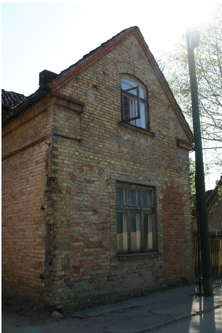
Policijas_12_62010060050002_fasade2 Ēkas ziemeļu fasāde.
