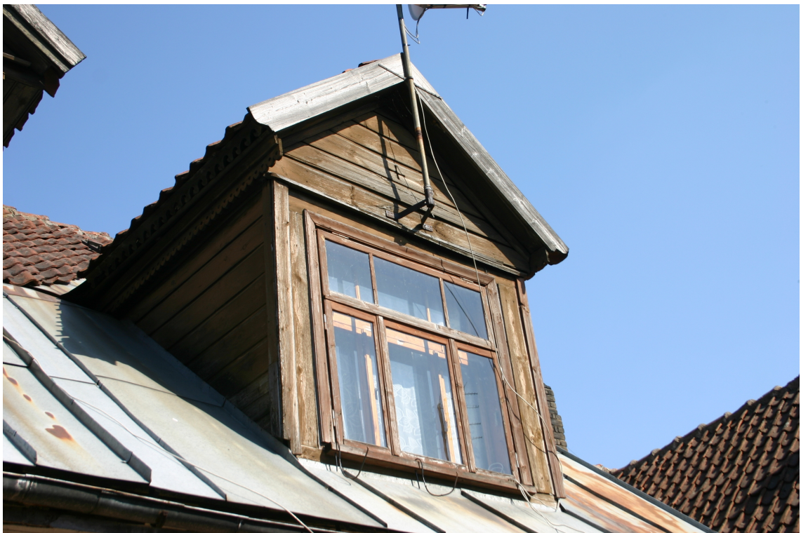
Policijas_12_62010060050001_fragments2 Vēsturiska jumta izbūve ar oriģinālo apšuvumu un detaļām. Logs un loga apmales 20.gs.2.puse.
