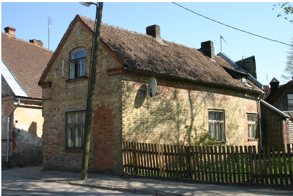
Policijas_12_62010060050002_fasade1 Skats uz ēku no ziemeļrietumiem. Redzama 20.gs.2.puses jumta izbūve.
