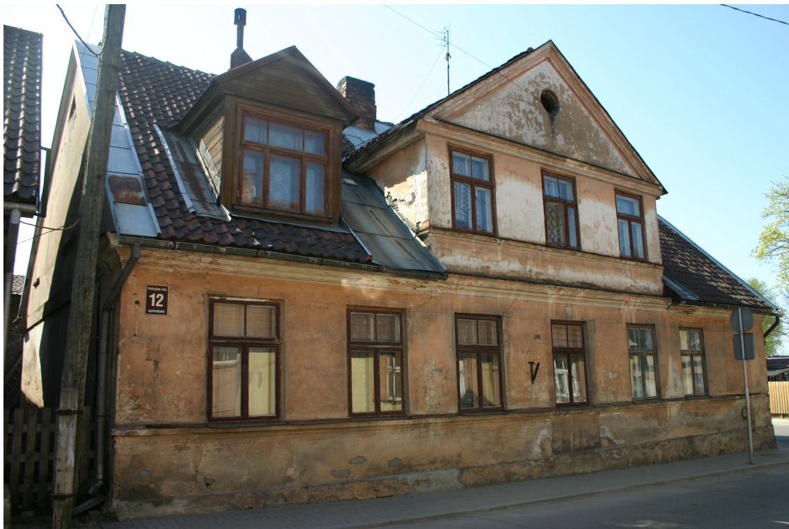
Policijas_12_62010060050001_fasade1 Skats uz ēku no austrumiem.
