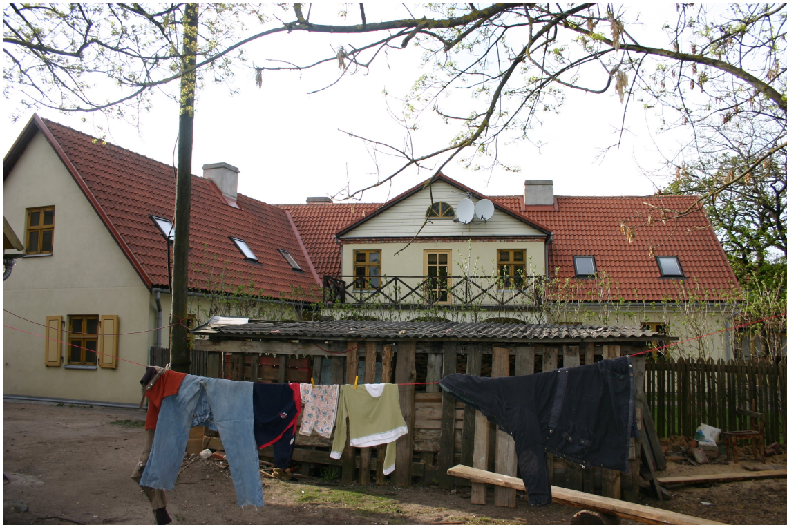
Policijas_11_62010060069001_fasade4 Skats uz ēku no dienvidaustrumiem.
