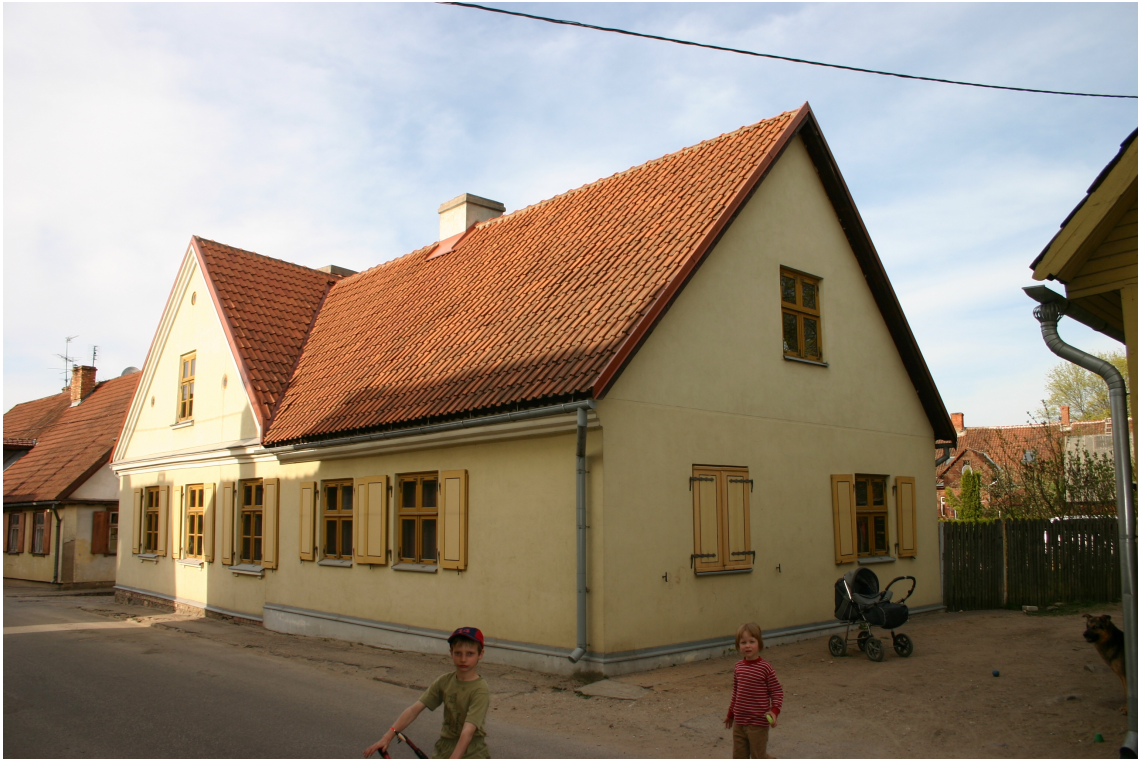
Policijas_11_62010060069001_fasade3 Skats uz ēku no dienvidrietumiem.
