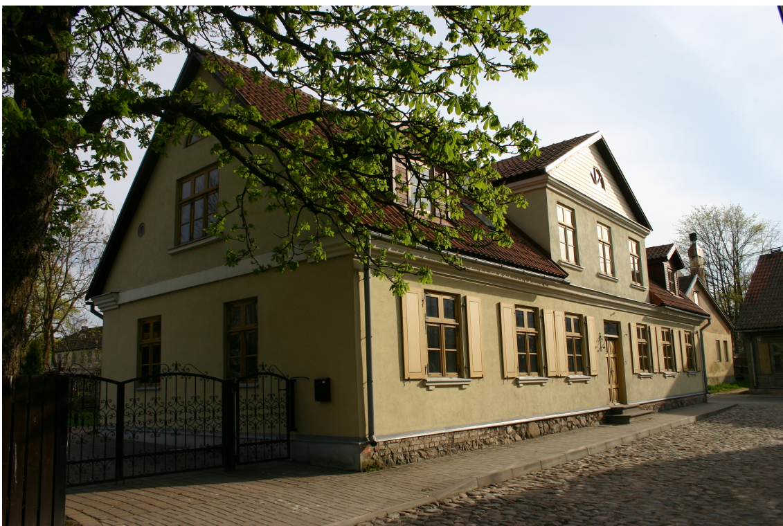
Policijas_11_62010060069001_fasade2 Skats uz ēku no ziemeļaustrumiem.
