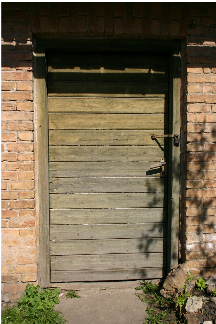
Policijas_10a_62010060049001_durvis1 Sākotnējās (20.gs.sāk.) durvis ar oriģinālo aprīkojumu.
