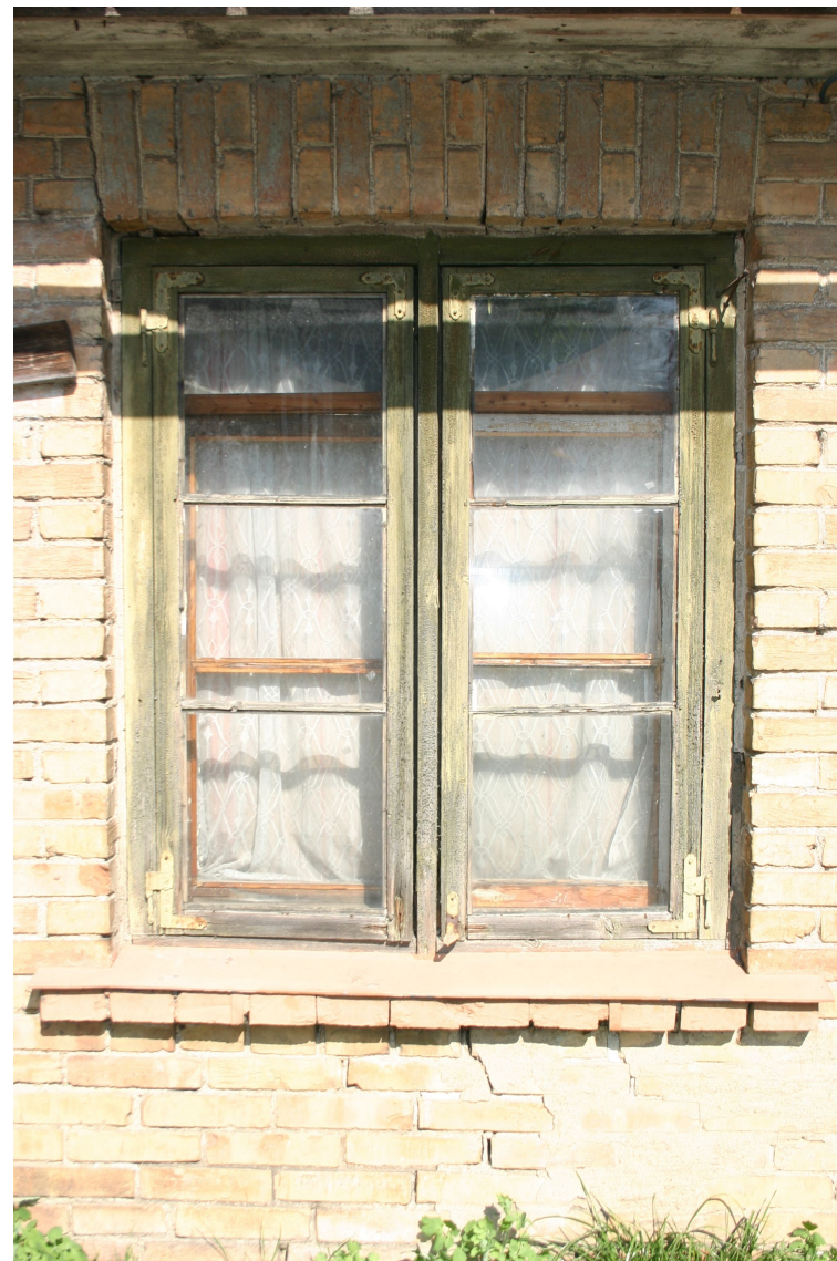
Policijas_10a_62010060049001_logs1 Sākotnējais (20.gs.sāk.) logs ar oriģinālo aprīkojumu.
