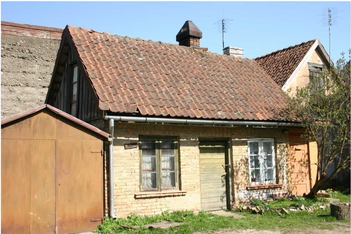
Policijas_10a_62010060049001_fasade1 Skats uz ēku no ziemeļrietumiem.
