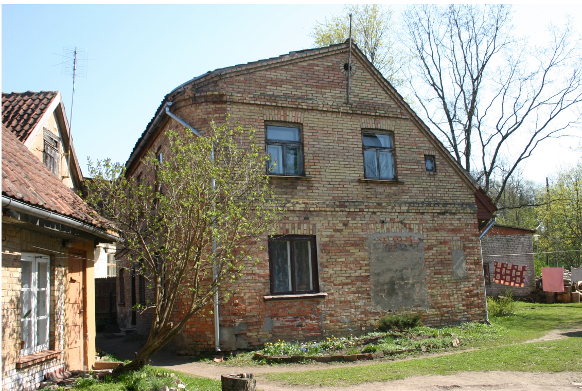
Policijas_10_62010060049002_fasade2 Skats uz ēku no ziemeļiem.
