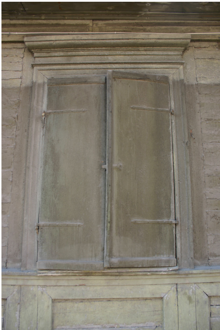
Polijas_10_62010060049001_slegi1 Sākotnējie (19.gs.3.cet.) slēgi ar aprīkojumu un logailas apdare.
