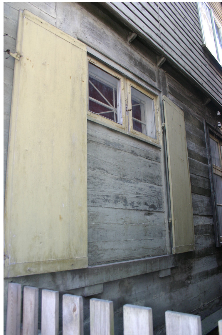
Policijas_10_62010060049001_fragments1 Galvenā korpusa ziemeļu fasādes fragments ar sākotnējo (19.gs.3.cet.) logu, loga apmalēm un slēgiem.
