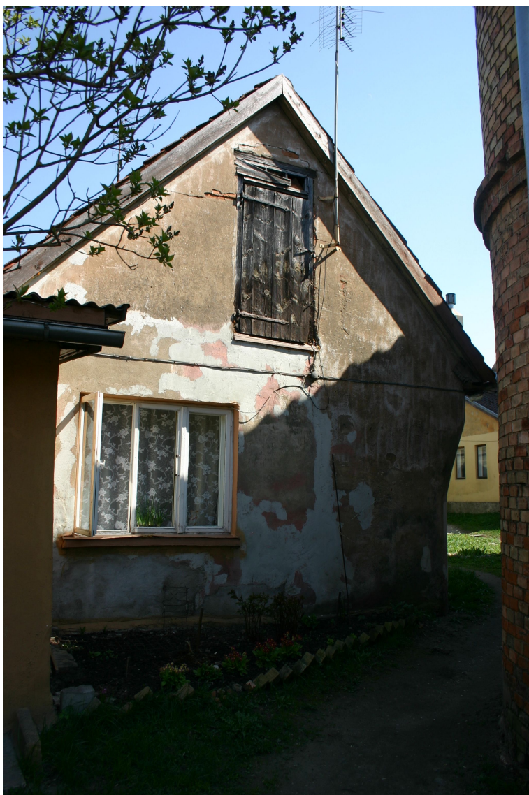
Policijas_10_62010060049001_fasade4 Skats uz 19.gs.3.cet. piebūves rietumu galu.
