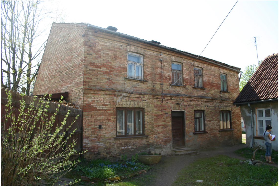
Policijas_10_62010060049002_fasade1 Skats uz ēku no austrumiem.
