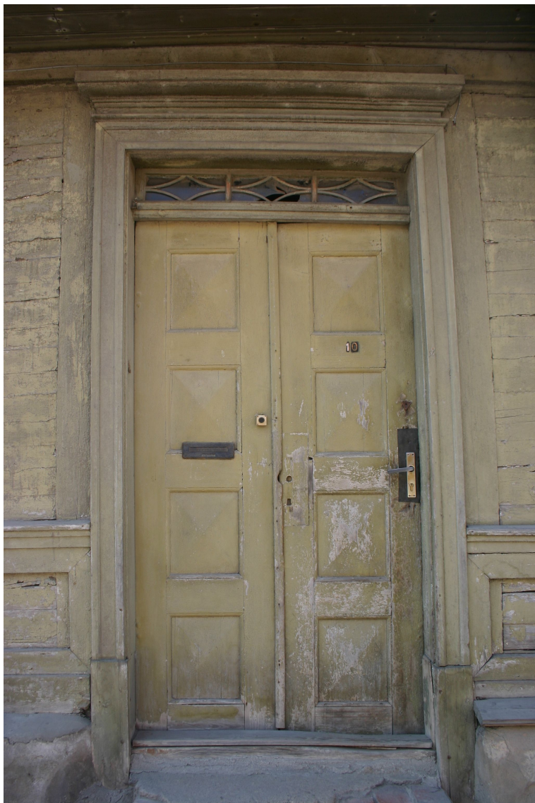
Policijas_10_62010060049001_durvis1 Sākotnējās (19.gs.3.cet.) durvis un virslogs. Durvju vērtņēm 20.gs.2.pusē pārveidots vēšanās virziens.
