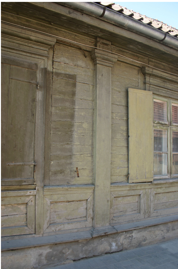
Policijas_10_62010060049001_fragments2 Galvenās fasādes fragments ar sākotnējo (19.gs.3.cet.) apdari.
