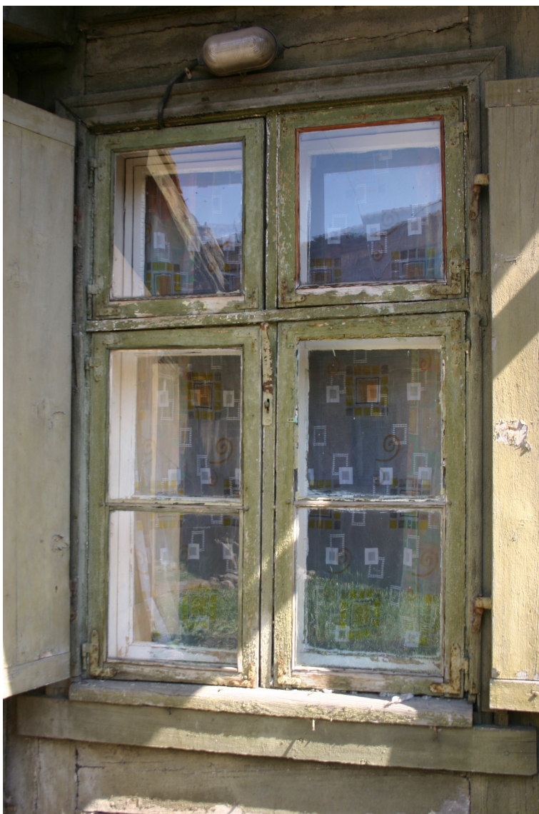
Policijas_10_62010060049001_logs1 20.gs.sāk. logs ar oriģinālo aprikojumu.
