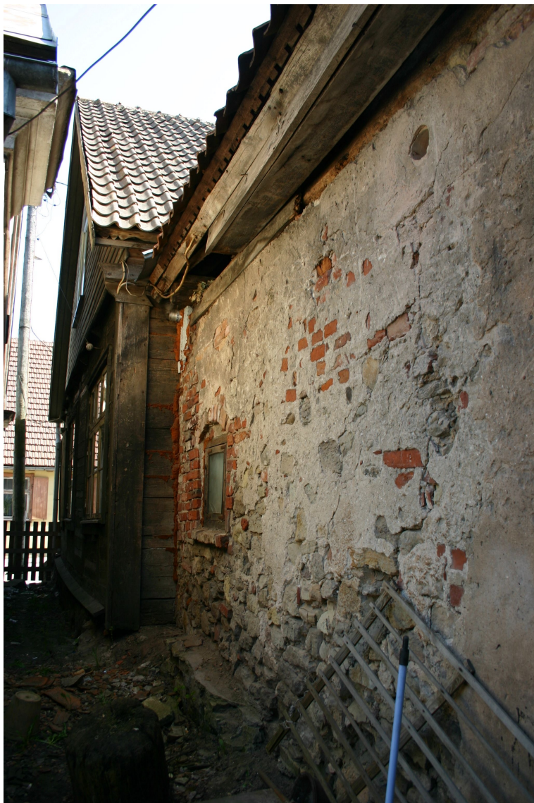
Policijas_10_62010060049001_fasade5 Skats uz galvenā korpusa un piebūves ziemeļu fasādēm.
