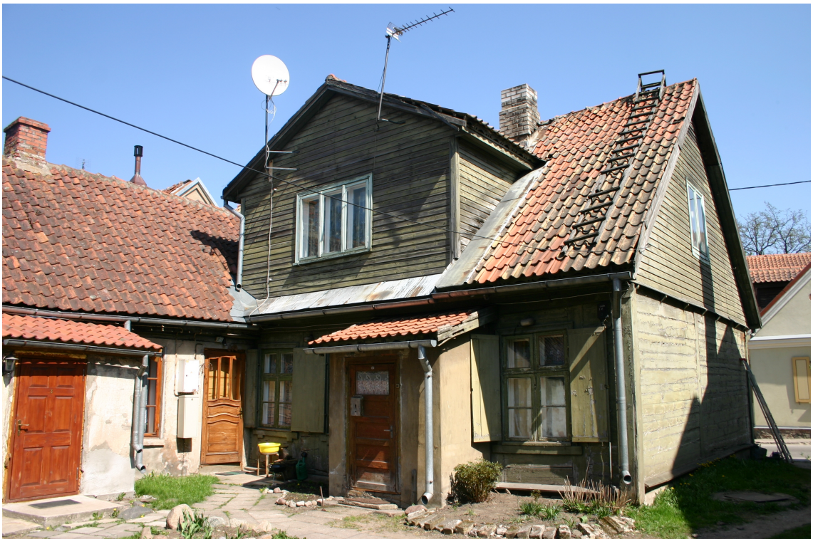
Policijas_10_62010060049001_fasade2 Skats uz ēku no dienvidrietumiem. Kreisajā pusē esošā piebūve uzcelta nedaudz vēlāk par ēku. Abas mazās piebūves datējamas ar 20.gs.2.pusi.
