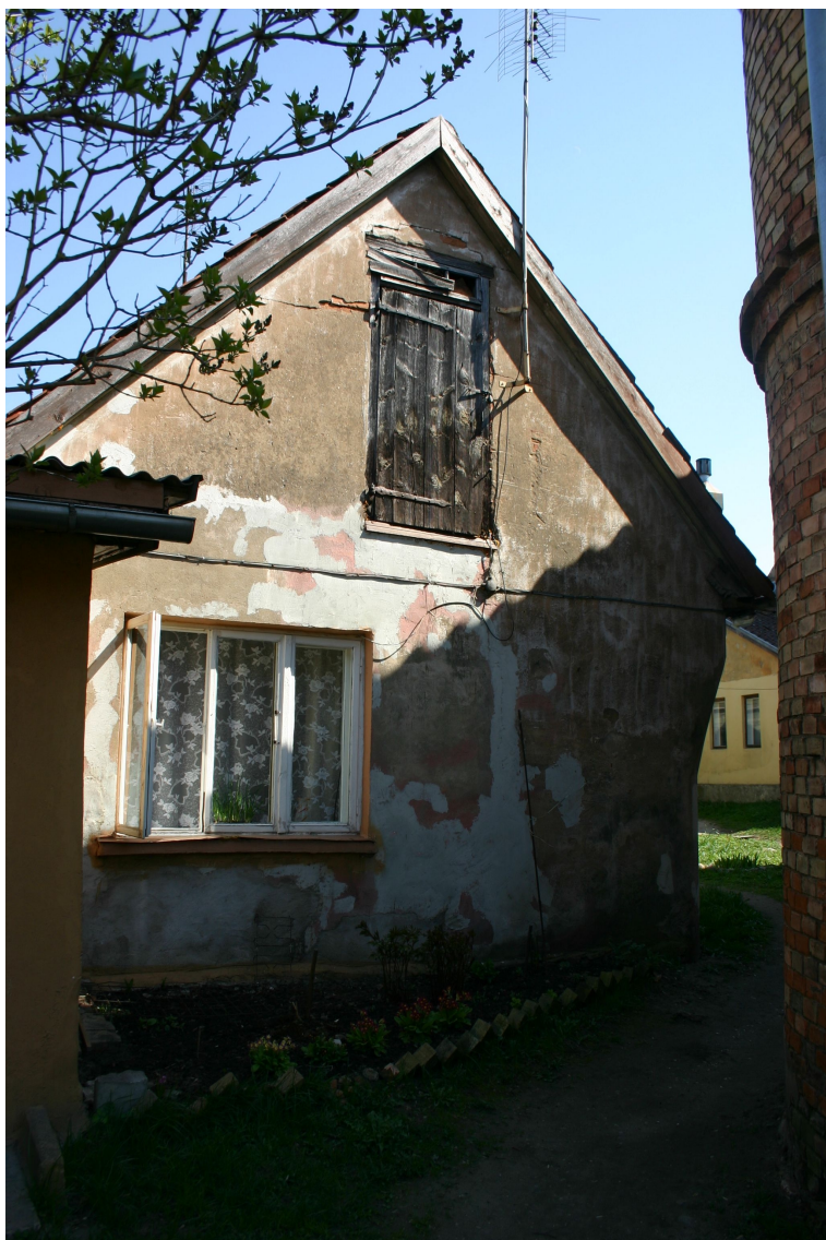
Policijas_10_62010060049001_fasade4 Skats uz 19.gs.3.cet. piebūves rietumu galu.
