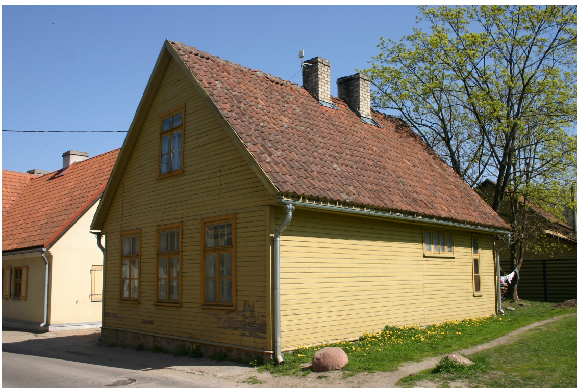
Policijas_9_62010060020001_fasade2 Skats uz ēku no dienvidrietumiem.
