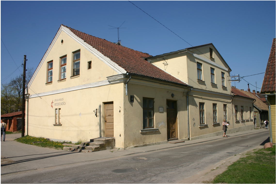
Policijas_8_62010060070001_fasade1 Skats uz ēku no dienvidaustrumiem.
