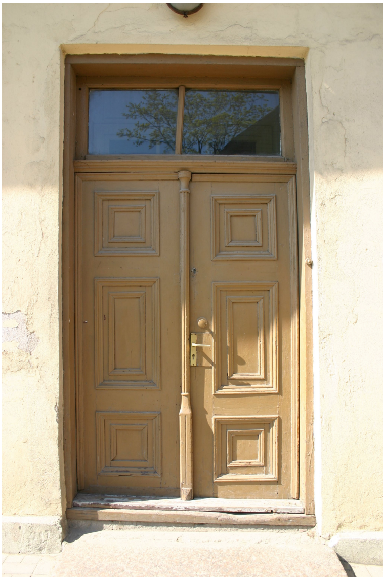
Policijas_8_62010060070001_durvis1 Durvis ar virslogu (19.gs.b.). Virslogam sekundārs spraislis.
