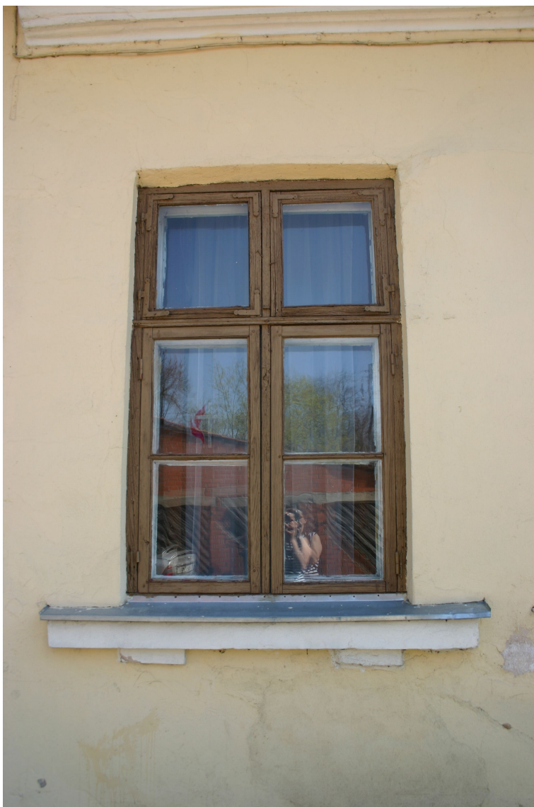
Policijas_8_62010060070001_logs1 19.gs.3.cet. logs un mūra palodze. Apakšējās vērtnes sekundāras.
