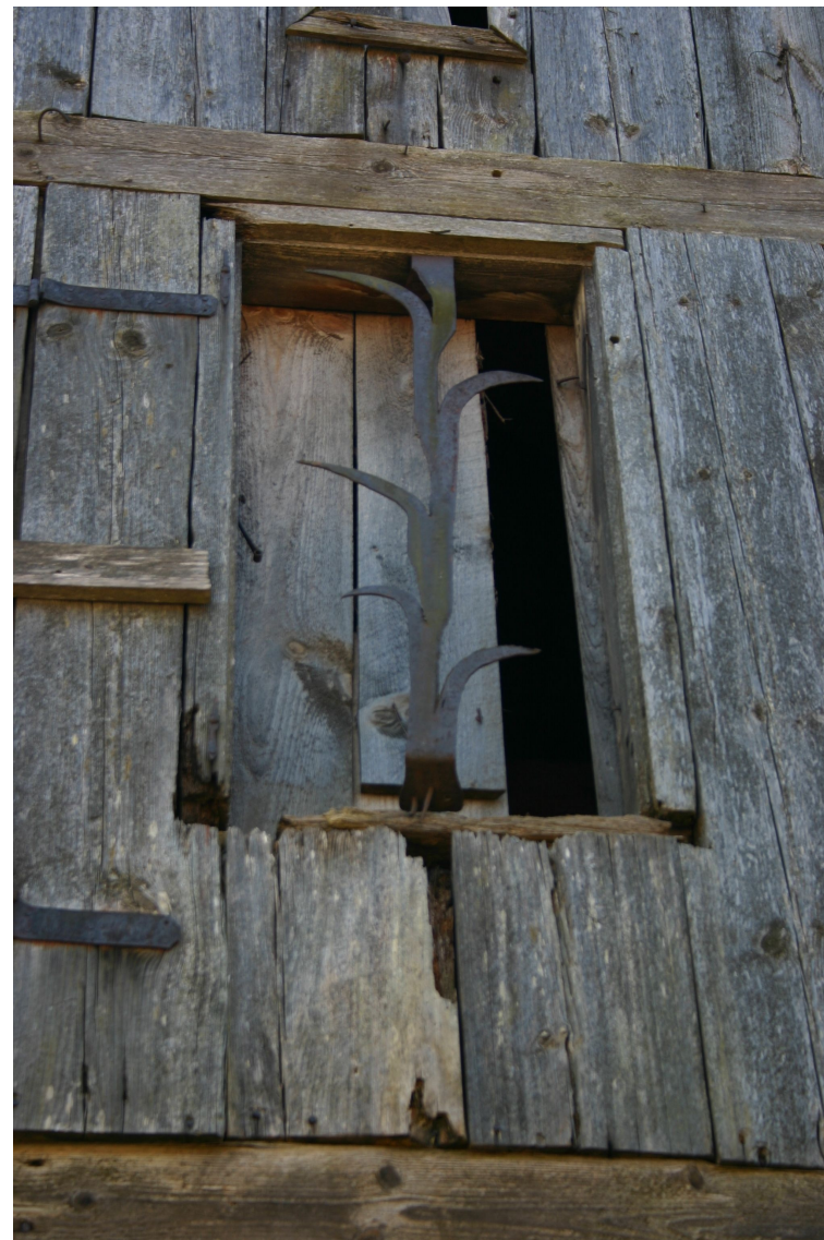
Polijas_6a_62010060080002_restes1 Sākotnēja (1839.-1870to gadu sāk.) loga aploda ar viru kāšiem un metāla reste.
