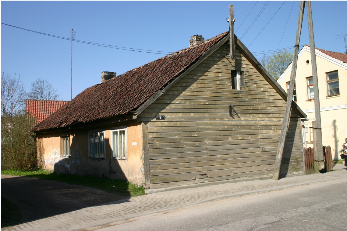
Policijas_6a_62010060080001_fasāde1 Skats uz ēku no dienvidaustrumiem.
