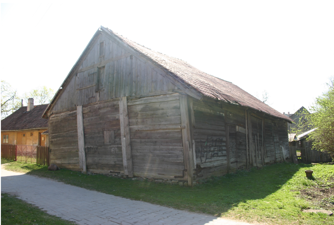
Policijas_6a_62010060080002_fasade2 Skats uz ēku no ziemeļrietumiem.
