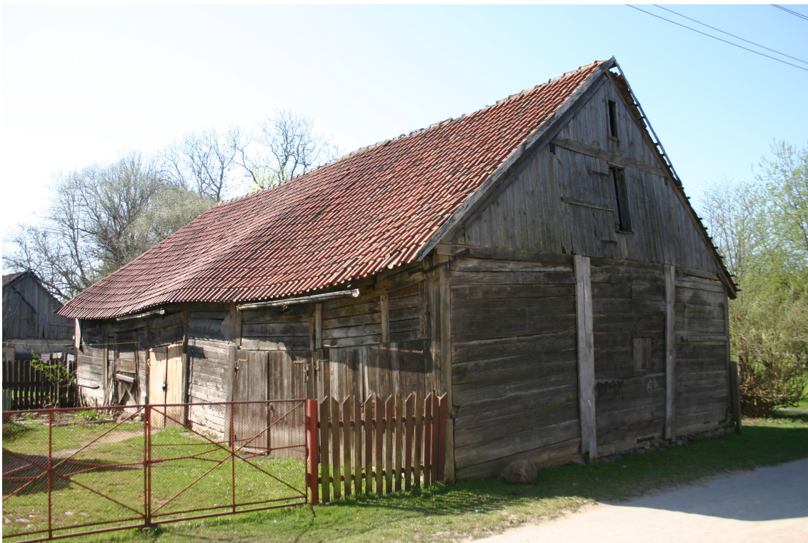
Policijas_6a_62010060080002_fasade1 Skats uz ēku no ziemeļaustrumiem.
