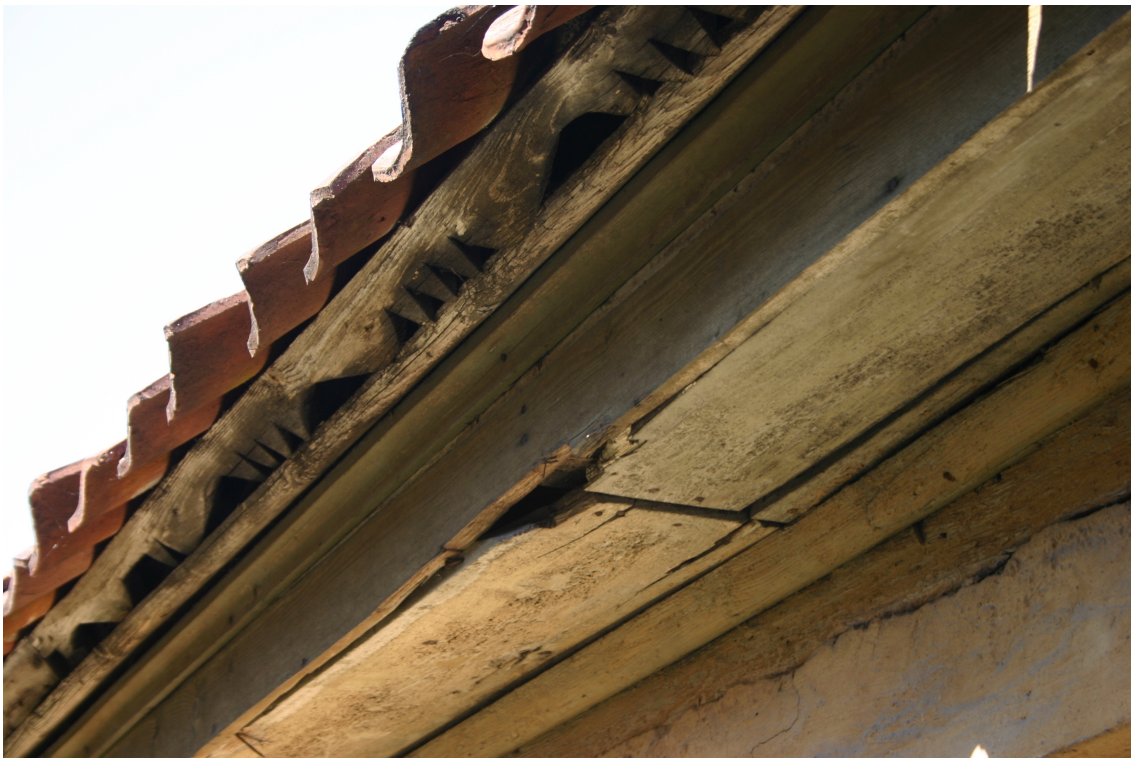
Policijas_6a_62010060080001_dzega1 Vēsturiska dēļu dzega un kokā griezts aizsegdēlis.
