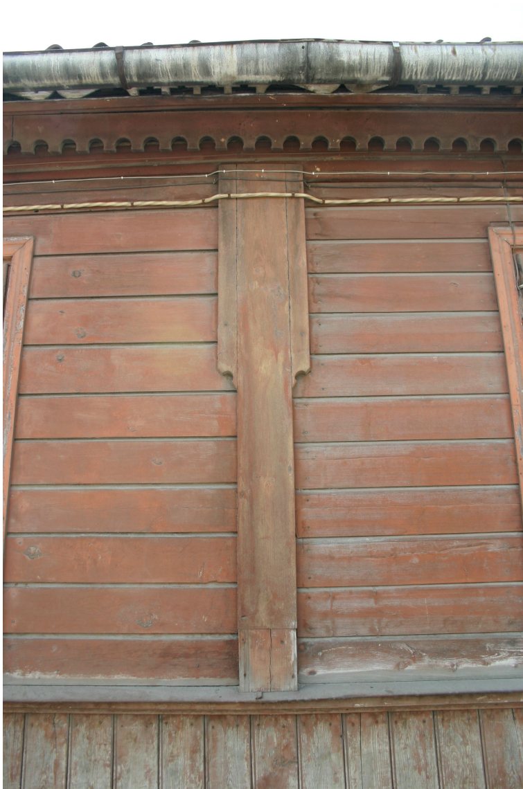
Policijas_6_62010060025001_detala Galvenās fasādes fragments ar 19.gs.4.cet. apdari. Vertikālie un labajā pusē esošie horizontālie dēļi datējami ar 20.gs.2.pusi.
