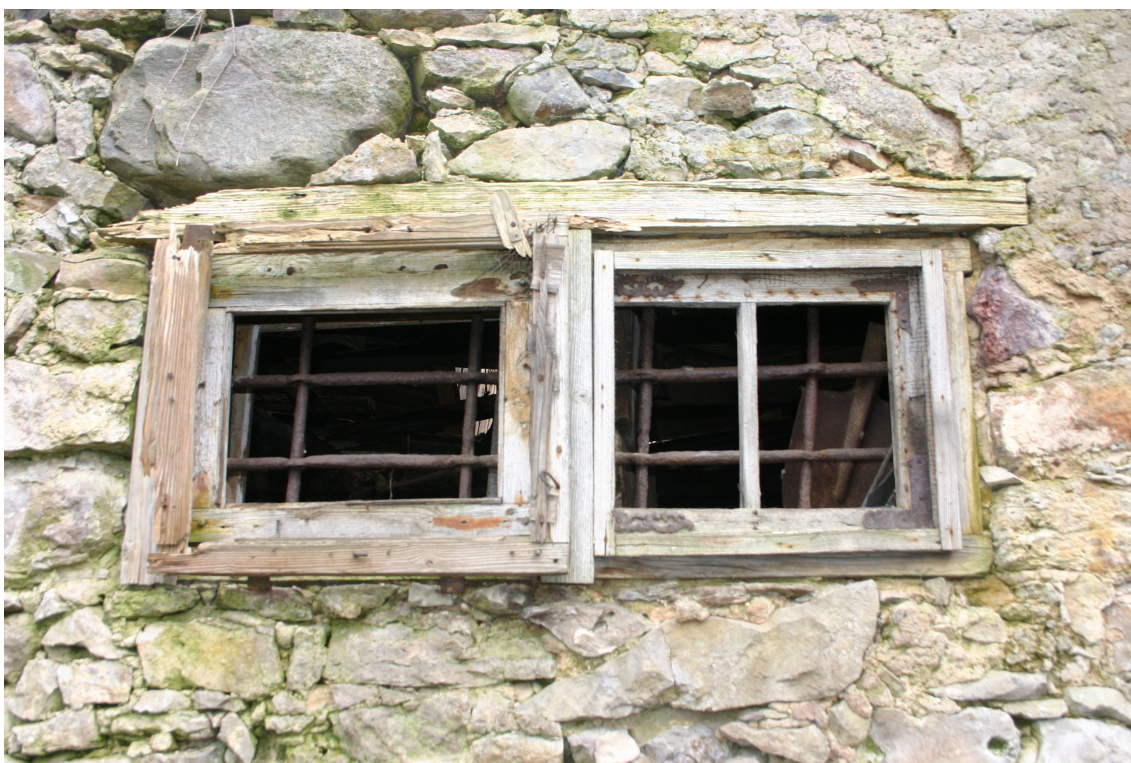
Policijas_4_62010060068003_logs1 Sākotnējs logs ar atkārtoti izmantotām virām un stūreņiem
