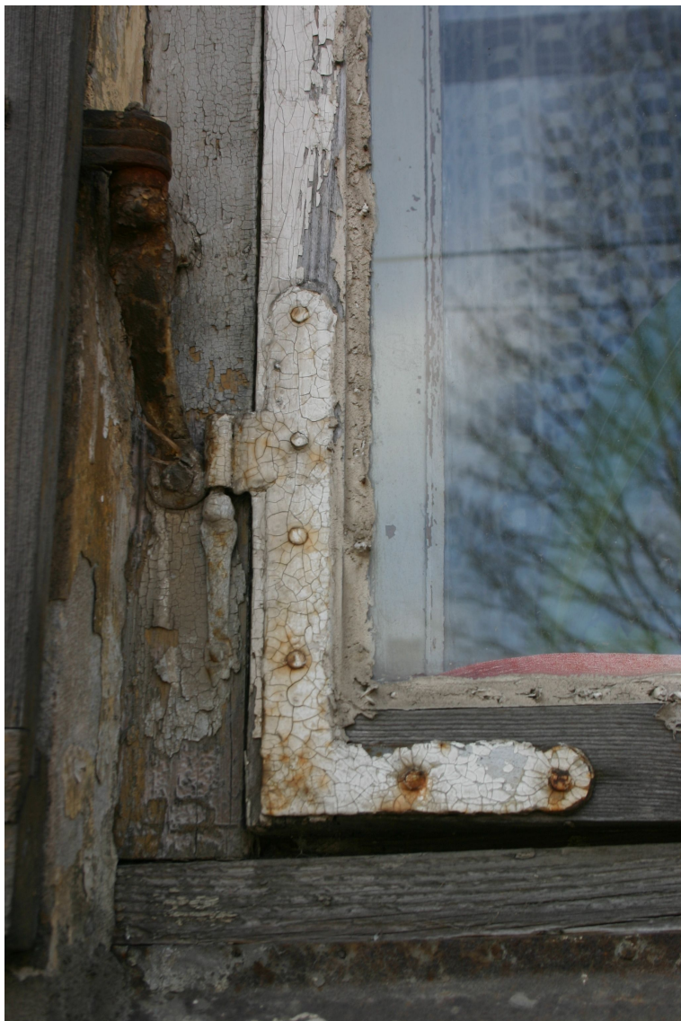
Policijas_4_62010060068001_logs3 Loga un slēga aprīkojums (1861.-1870to sākums).
