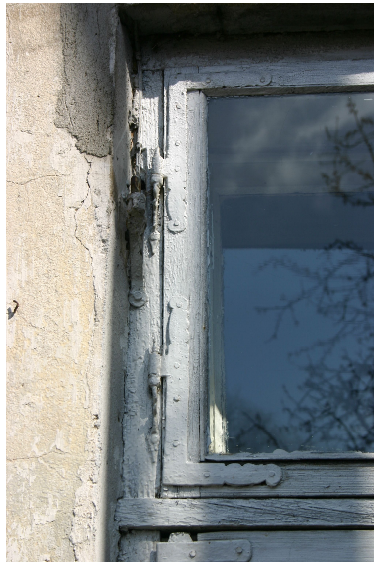
Policijas_4_62010060068001_logs4 Atkārtoti izmantotas loga viras (18.gs.pēd.cet.)
