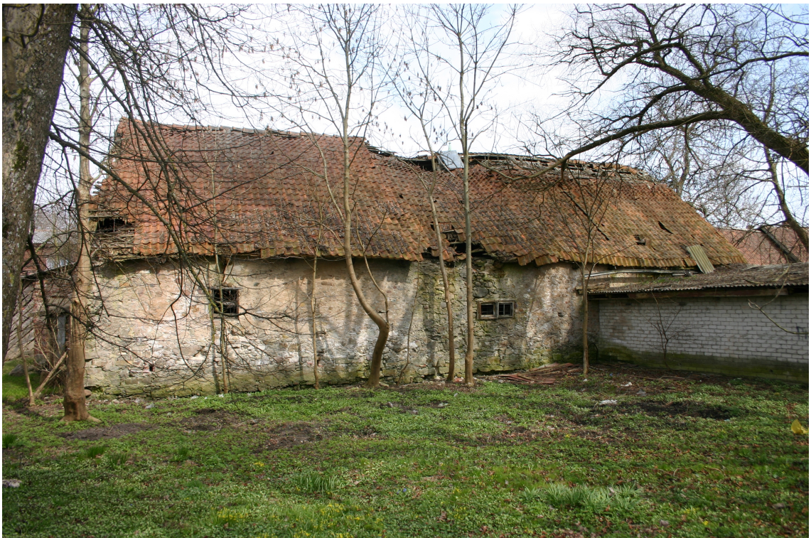
Policijas_4_62010060068003_fasade2 Skats uz ēku no dienvidrietumiem.
