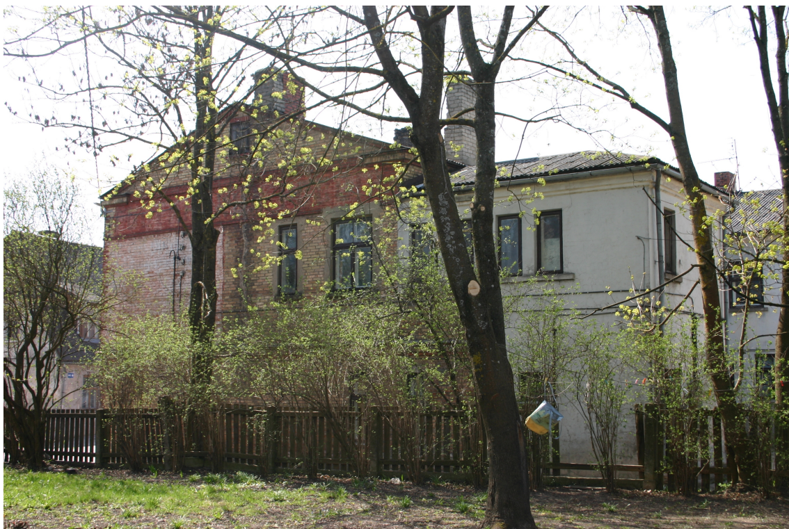
Policijas1a_62010060047001_fasāde3 Skats uz ēku no ziemeļaustrumiem.
