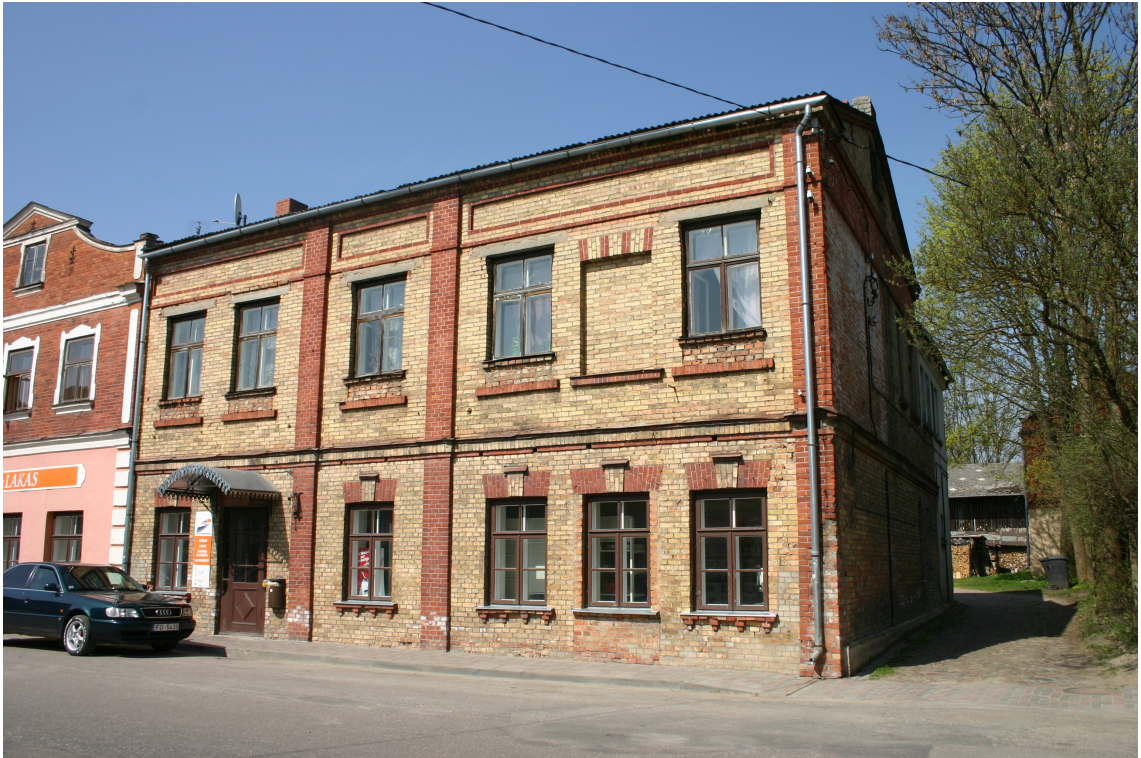
Policijas1a_62010060047001_fasāde1 Ēka skatā no dienvidaustrumiem. 20.gs.2.pusē uz augšu paceltas 2.stāva logailas un 1.stāvā viena durvjaila pārveidota par logailu.
