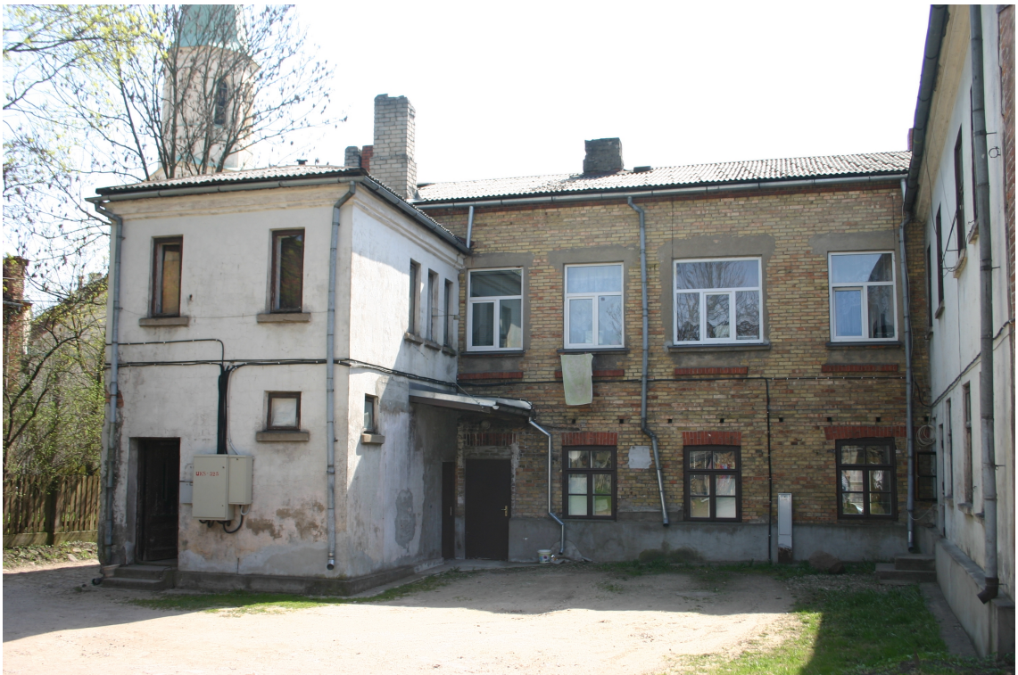
Policijas1a_62010060047001_fasāde2 Skats uz ēku no ziemeļrietumiem. 20.gs.2.pusē uz augšu paceltas 2.stāva logailas. Piebūve uzcelta 20.gs.50.,60.gados.
