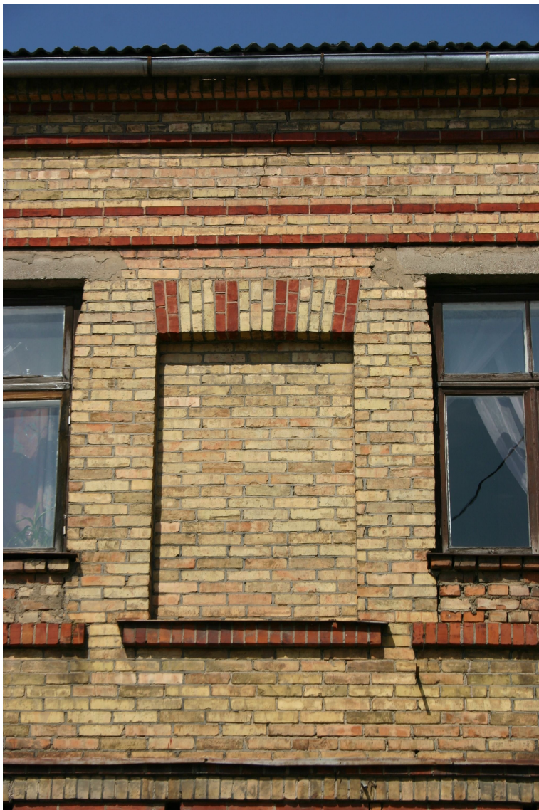
Policijas1a_62010060047001_fragments2 Ielas fasādes 1.stāva fragments ar sākotnējo (20.gs.sāk.) fasāžu apdari. Malējās logailas pārveidotas 20.gs.2.pusē.
