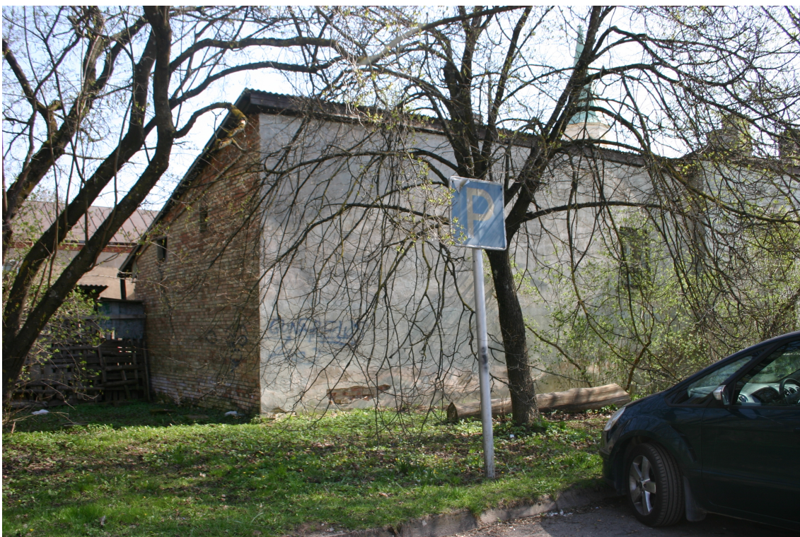
Policijas_1_62010060047002_007_fasade2 Skats uz ēku no ziemeļrietumiem.
