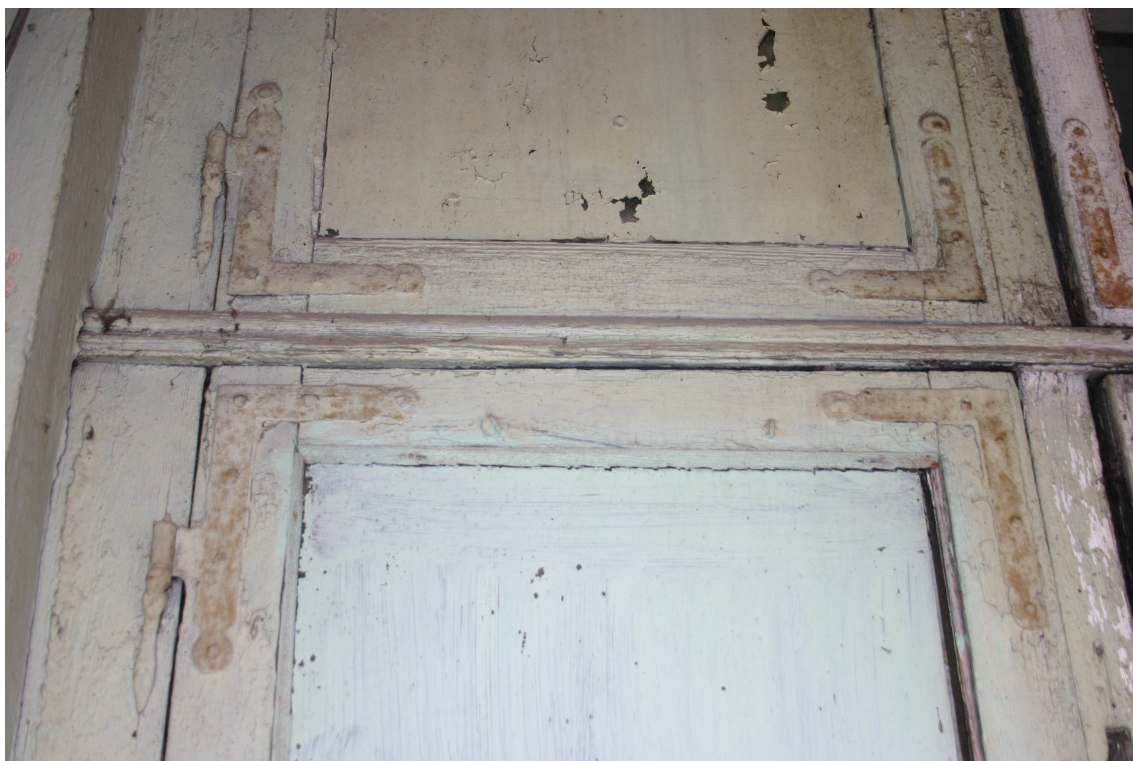
Policijas_1_62010060047001_logs2 Sākotnējā (19.gs.3.cet.) loga oriģinālais aprīkojums.
