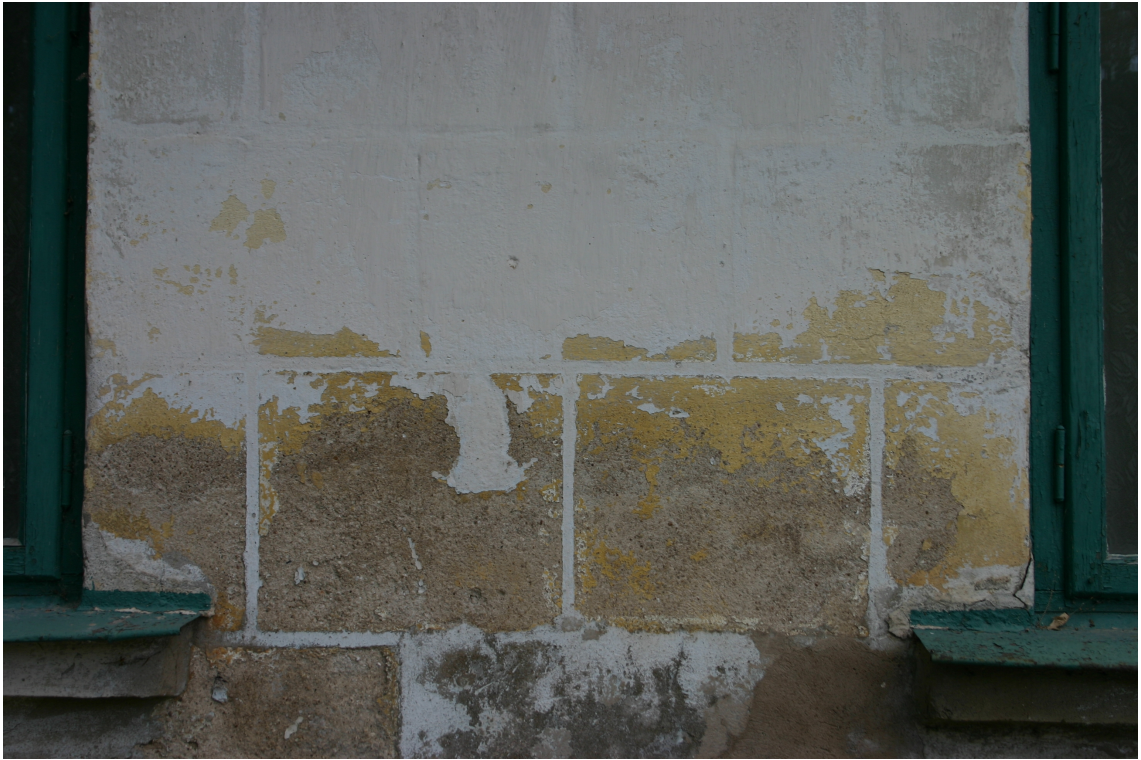
Pils_6_62010220080001_fragments1 Sākotnēji (19.gs.pēd.cet.) apmetumā vilkti rusti, kas 20.gs.2.pusē aizziesti ar apmetumu.
