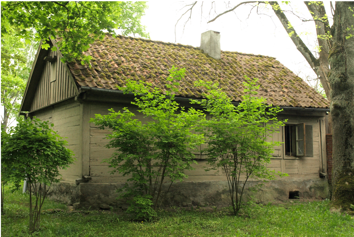
Pils_5_62010220090003_fasade3 Skats uz ēku no ziemeļrietumiem.
