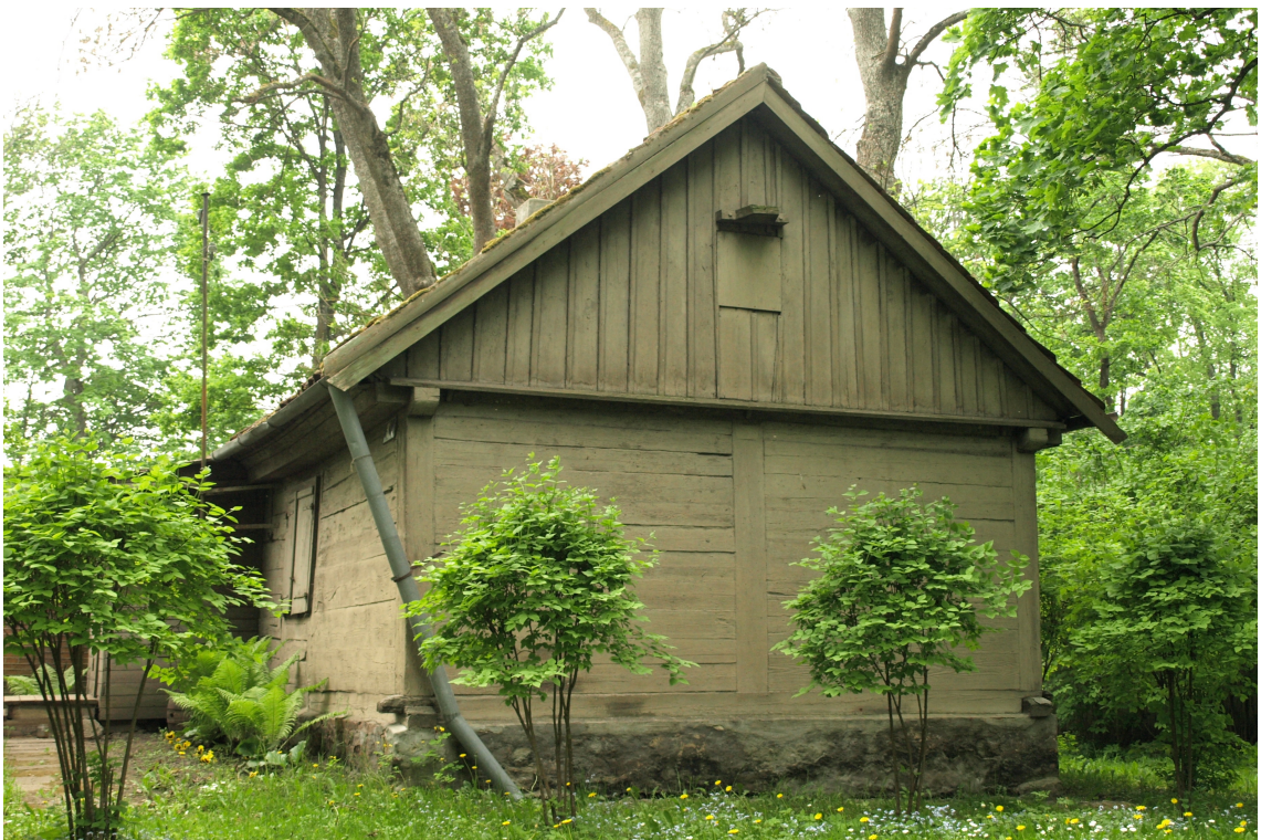
Pils_5_62010220090003_fasade2 Skats uz ēku no ziemeļaustrumiem.
