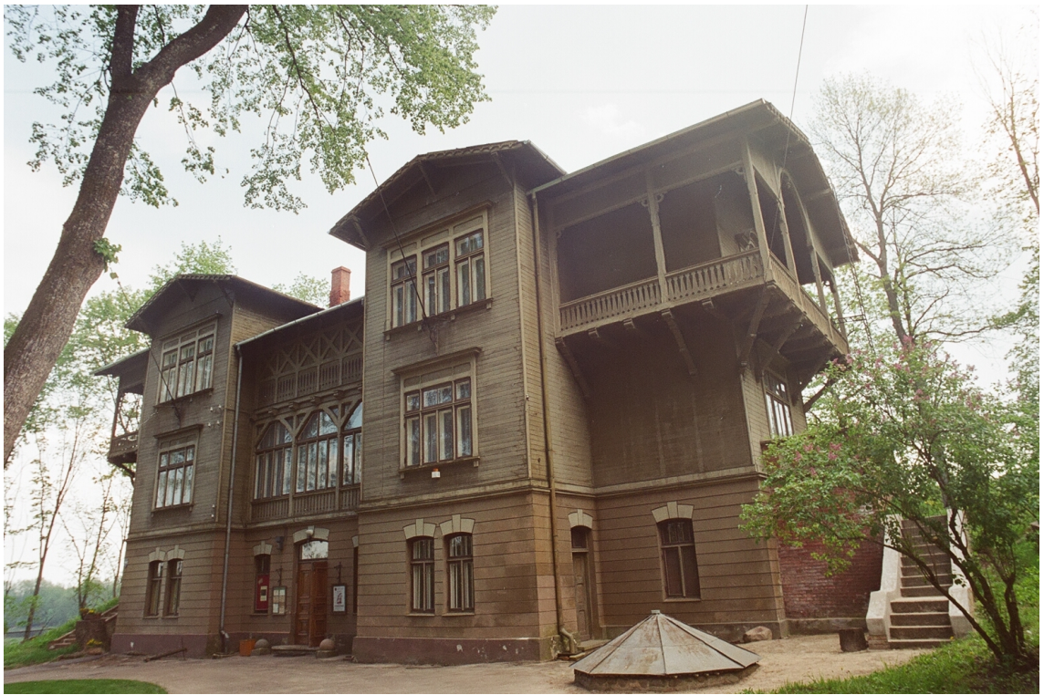
Pils_5_62010220090001_fasade1 Skats uz ēku no ziemeļrietumiem.
