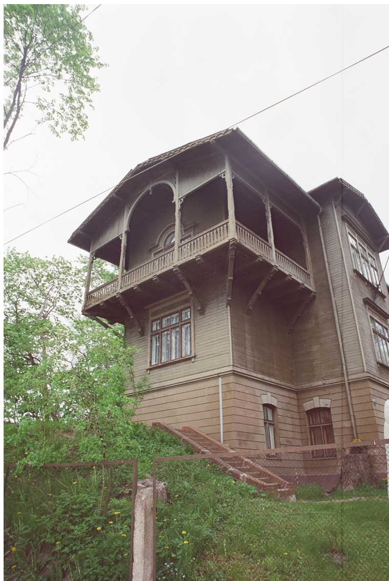
Pils_5_62010220090001_fasade4 Skats uz ēku no ziemeļaustrumiem.
