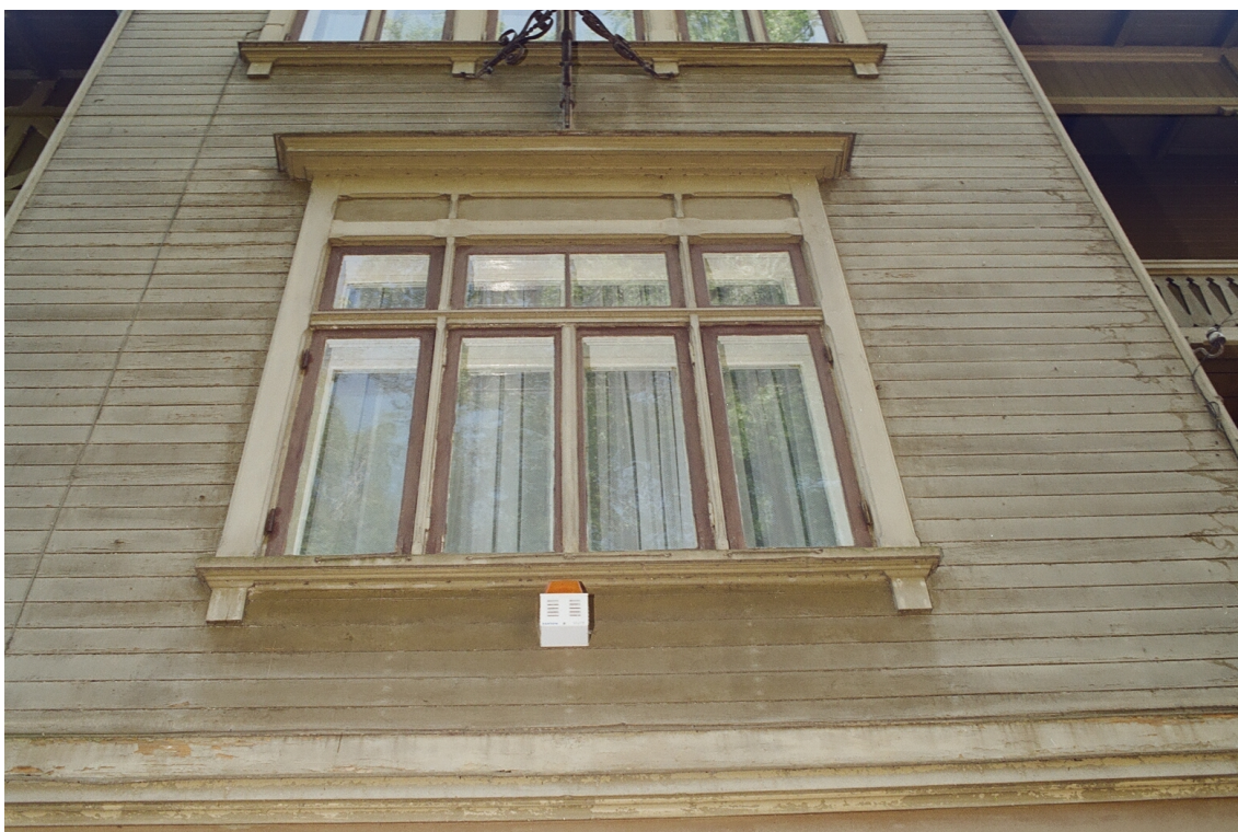
Pils_5_62010220090001_logs1 Sākotnējais (1906.g.) logs ar oriģinālo aprīkojumu, apmalēm, palodzi un sandriku.
