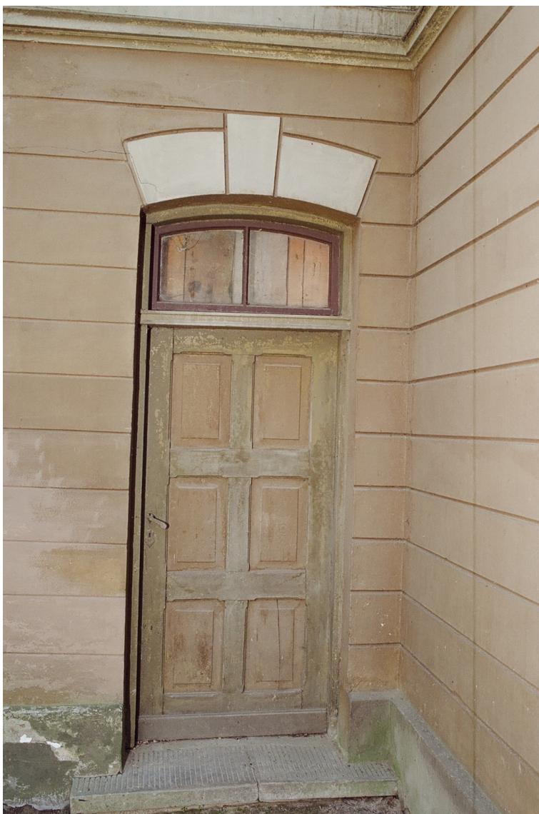
Pils_5_62010220090001_durvis2 Sākotnējo (1906.g.) durvju komplekts ar oriģinālo aprīkojumu.
