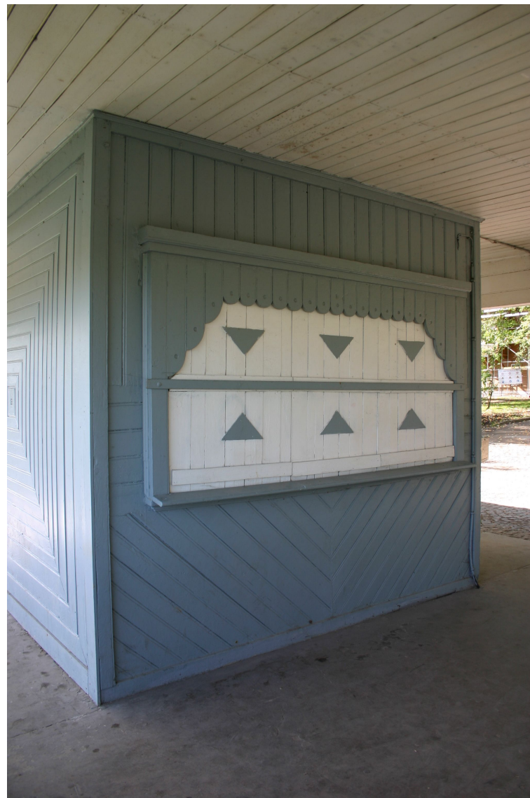
Pils_4a_62010220096001_fragments2 Sākotnējs (1937.g.) dēļu apšuvums (stipri labots). Iespējams, daļēji sākotnēji slēgi un aillas apdare.
