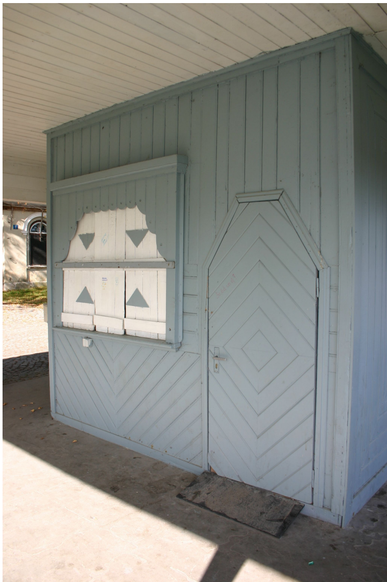
Pils_4a_62010220096001_fragments1 Sākotnējs (1937.g.) dēļu apšuvums (stipri labots). Iespējams, daļēji sākotnēji slēgi un aillas apdare. Durvis – 20.gs.2.puse.
