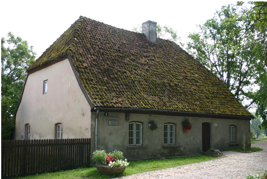
Pils_4_62010220124001_fasade1 Skats uz ēku no rietumiem.
