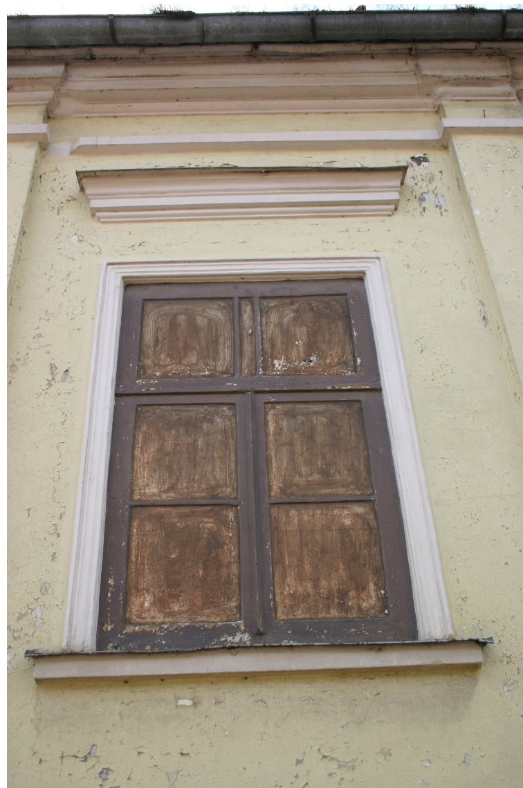
Pils_2_62010220031001_logs3 Sākotnējs (1870tie gadi), apmetumā veidots, "aklais" logs un logailas apdare.
