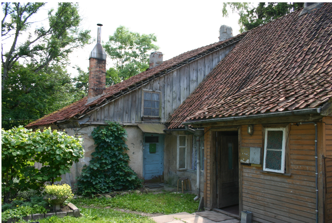
Pils_8_62010220047001_fasade4 Skats uz ēku no ziemeļaustrumiem.
