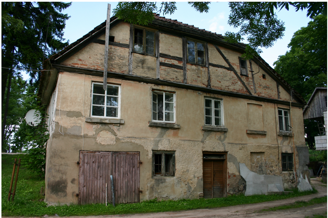
Pils_8_62010220047001_fasade6 Ēkas dienvidu fasāde.
