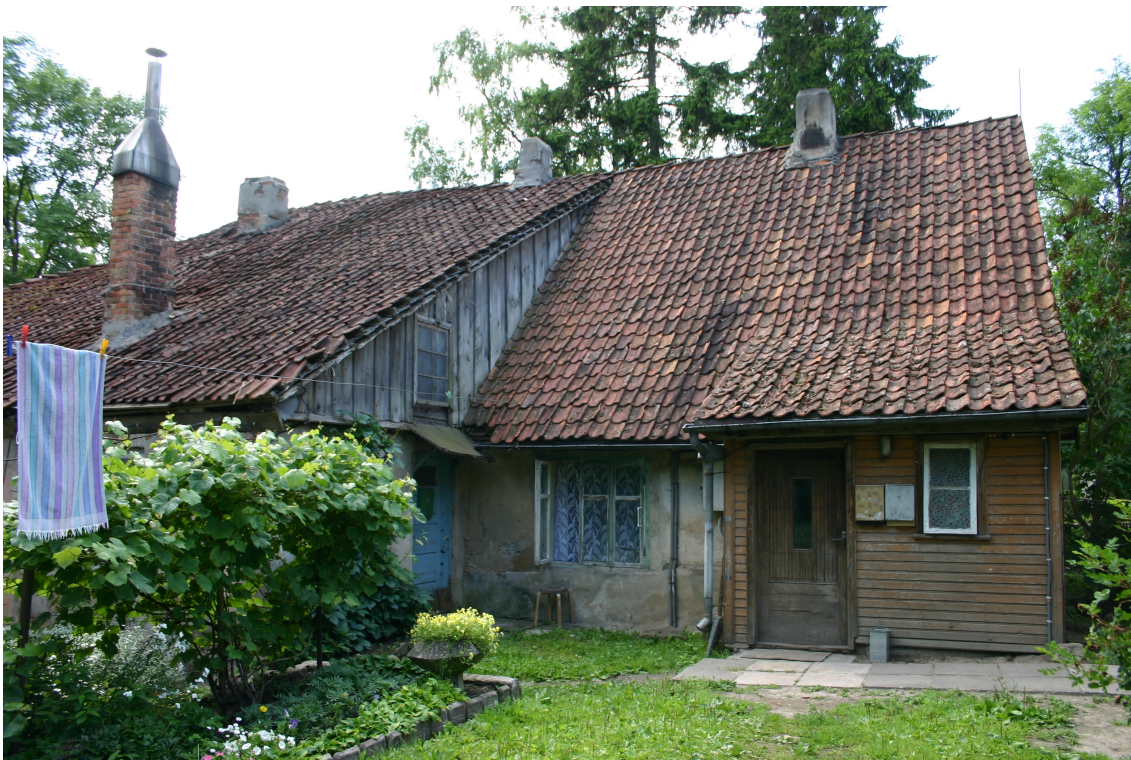
Pils_8_62010220047001_fasade3 Skats uz ēku no austrumiem. Piebūve – 20.gs.2.puse.
