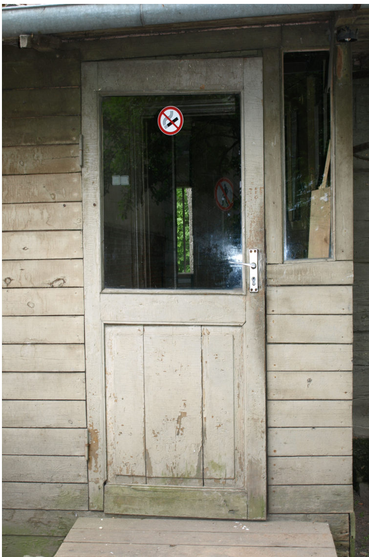
Pils_5_62010220090003_durvis1 Vēsturiskas iekšdurvis, kas šobrīd pārveidotas par ārdurvīm.
