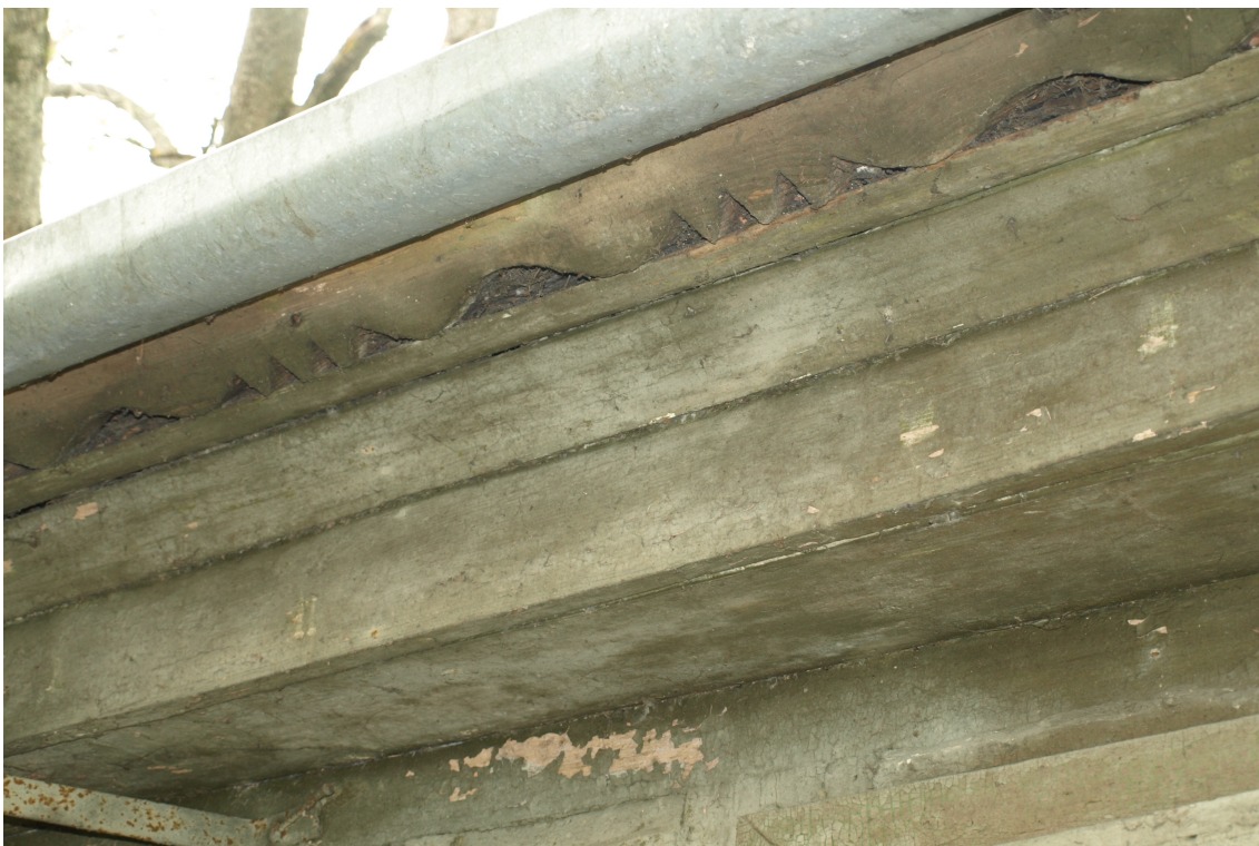
Pils_5_62010220090003_dzega1 Sākotnēja (19.gs.3.cet.) dēļu dzega un kokā griezts aizsegdēlis.
