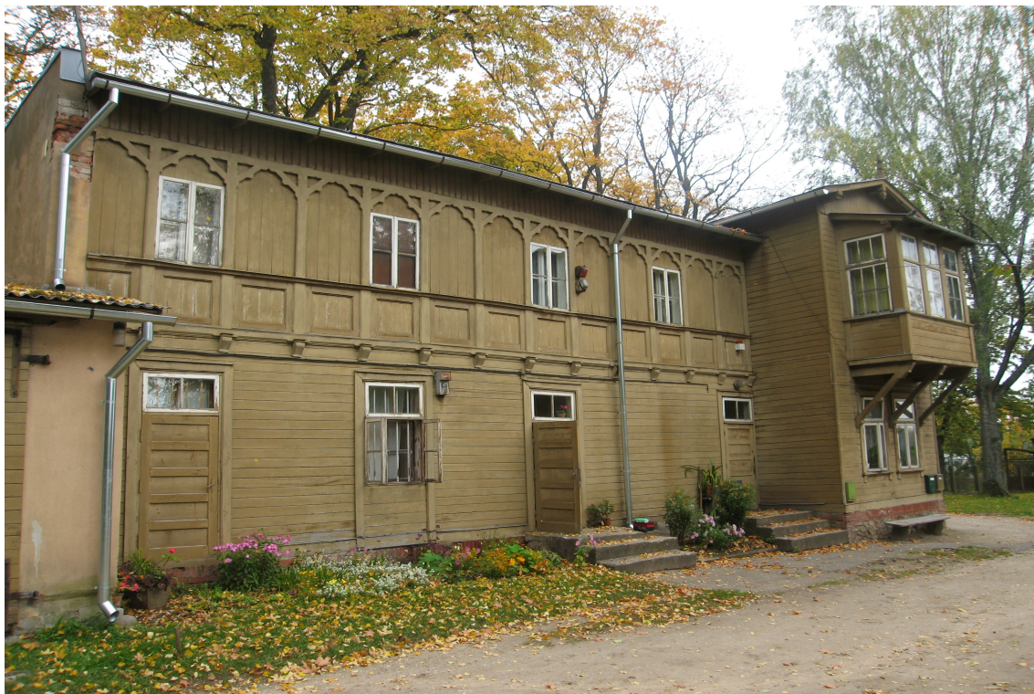
Pils_5_62010220090002_fasade1 Skats uz ēku no dienvidrietumiem.
