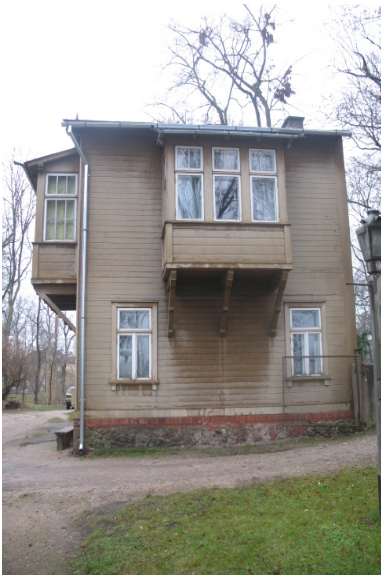
Pils_5_62010220090002_fasade3 Ēkas austrumu fasāde.
