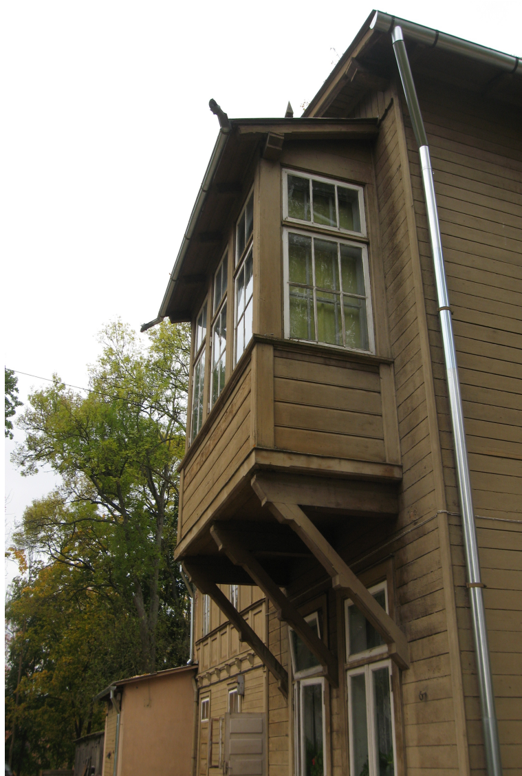
Pils_5_62010220090002_fragments2 Sākotnējais (1906.-1927.g.) erkens ar oriģinālajiem logiem.
