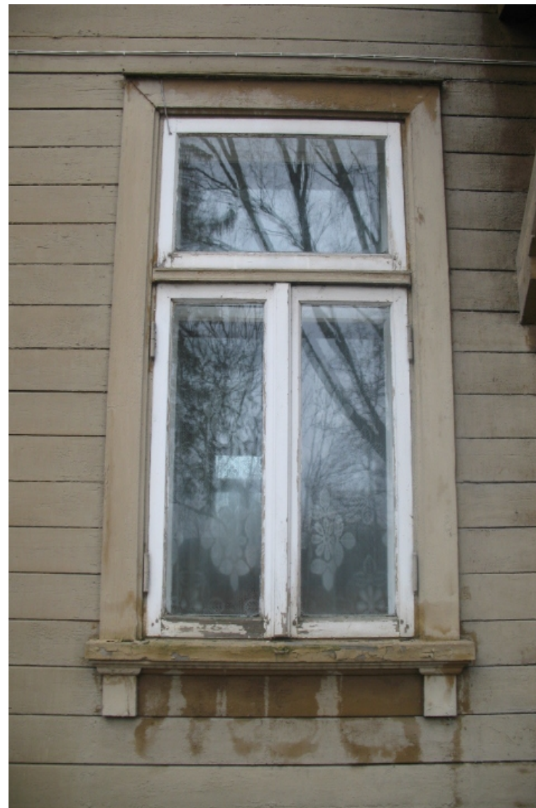
Pils_5_62010220090002_logs2 Sākotnēja (1906.-1927.g.) loga aploda, apmales un palodze.
