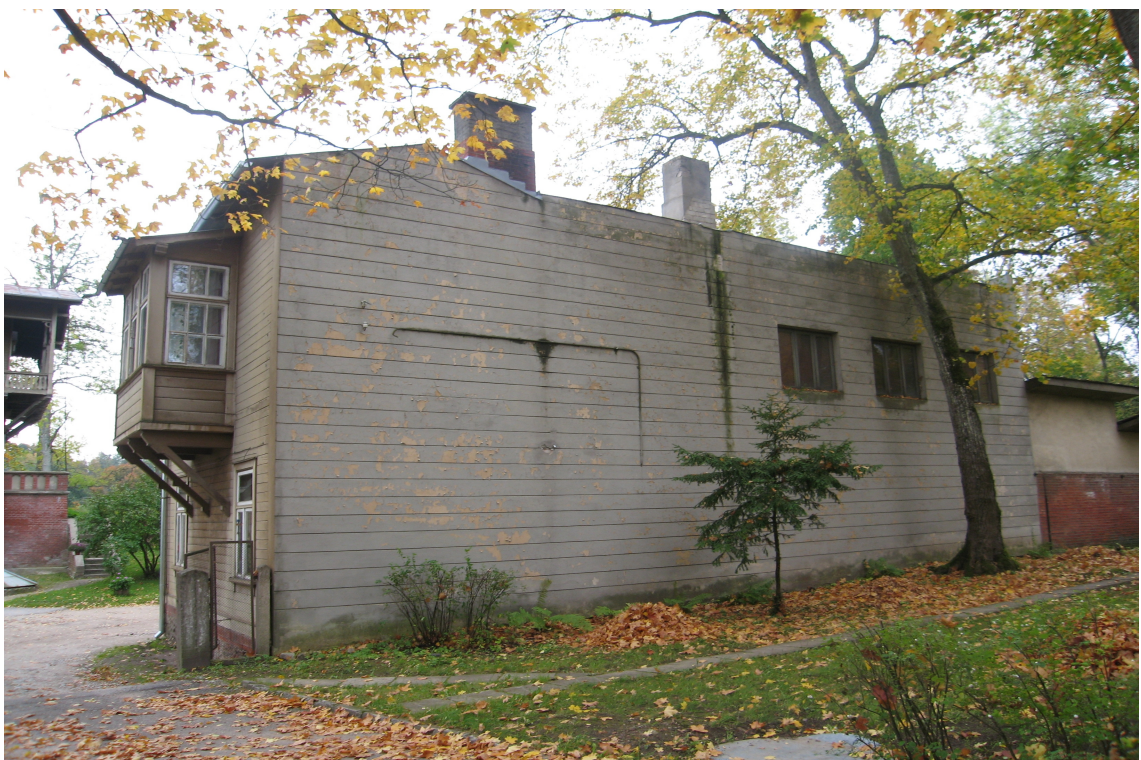
Pils_5_62010220090002_fasade4 Skats uz ēku no ziemeļaustrumiem.
