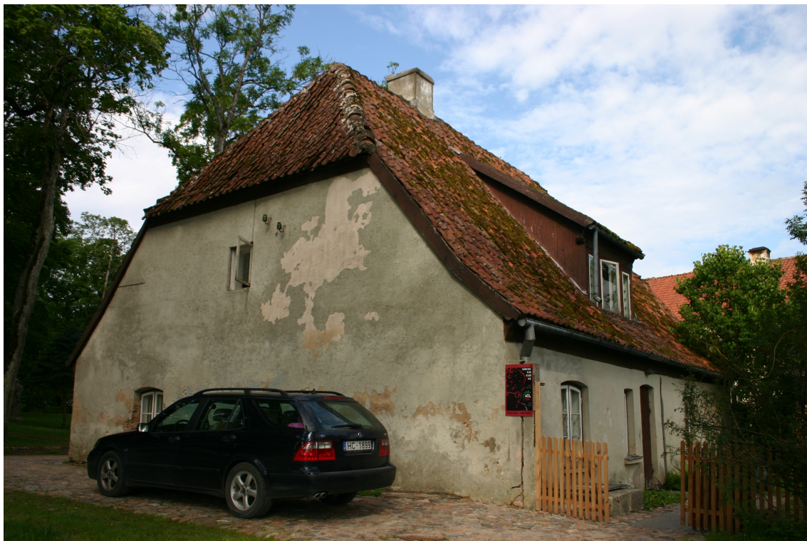
Pils_4_62010220124001_fasade3 Skats uz ēku no austrumiem.
