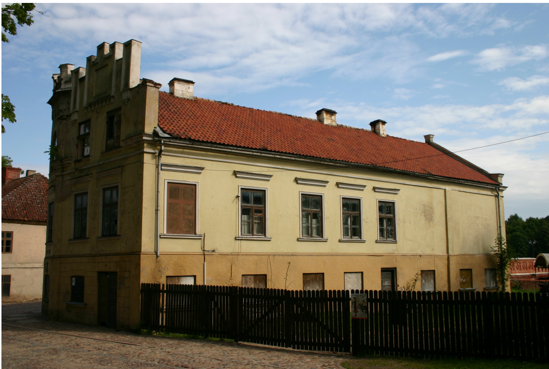
Pils_2_62010220031001_fasade3 Skats uz ēku no dienvidiem.
