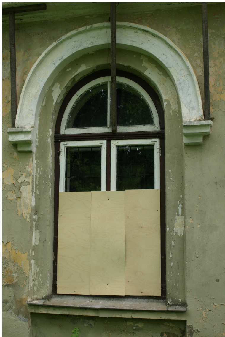
Pils_1_62010220088001_logs1 Vēsturiska (1839.-1870to gadu sāk.) loga aploda ar 20.gs.sāk. vērtņēm un aprīkojumu.
