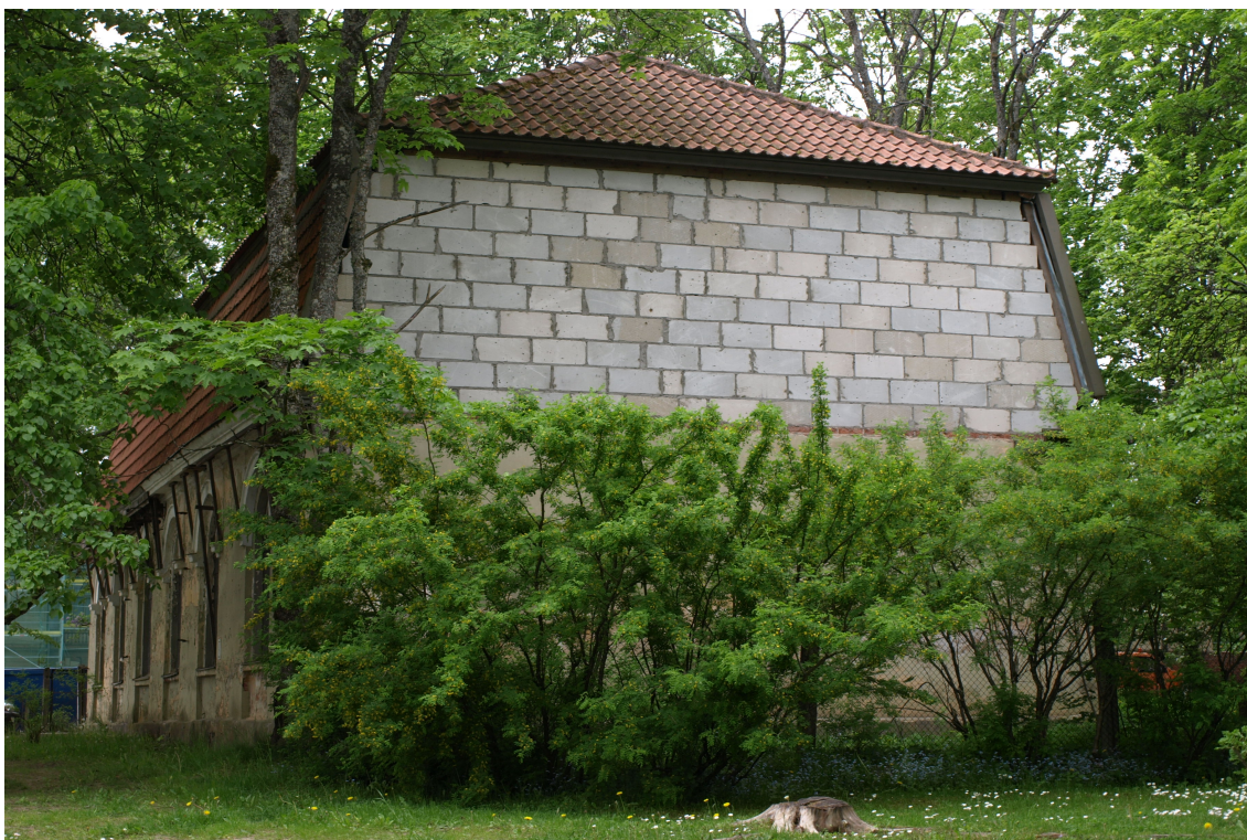
Pils_1_62010220088001_fasade3 Skats uz ēku no ziemeļaustrumiem.
