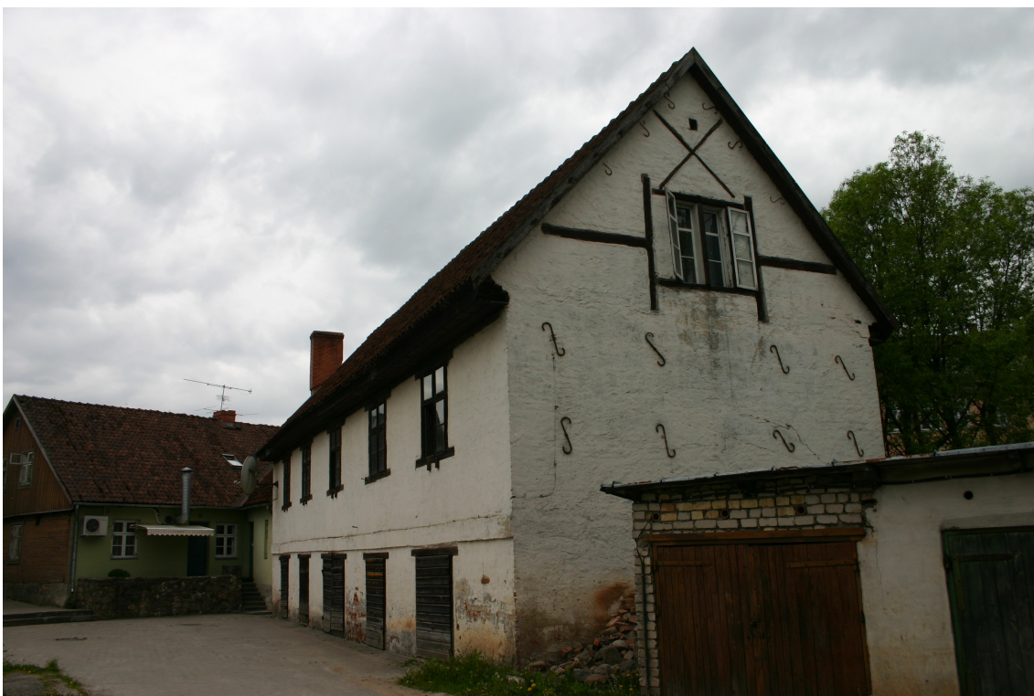
Pasta_5a_62010220046002_fasade2 Skats uz ēku no austrumiem.
