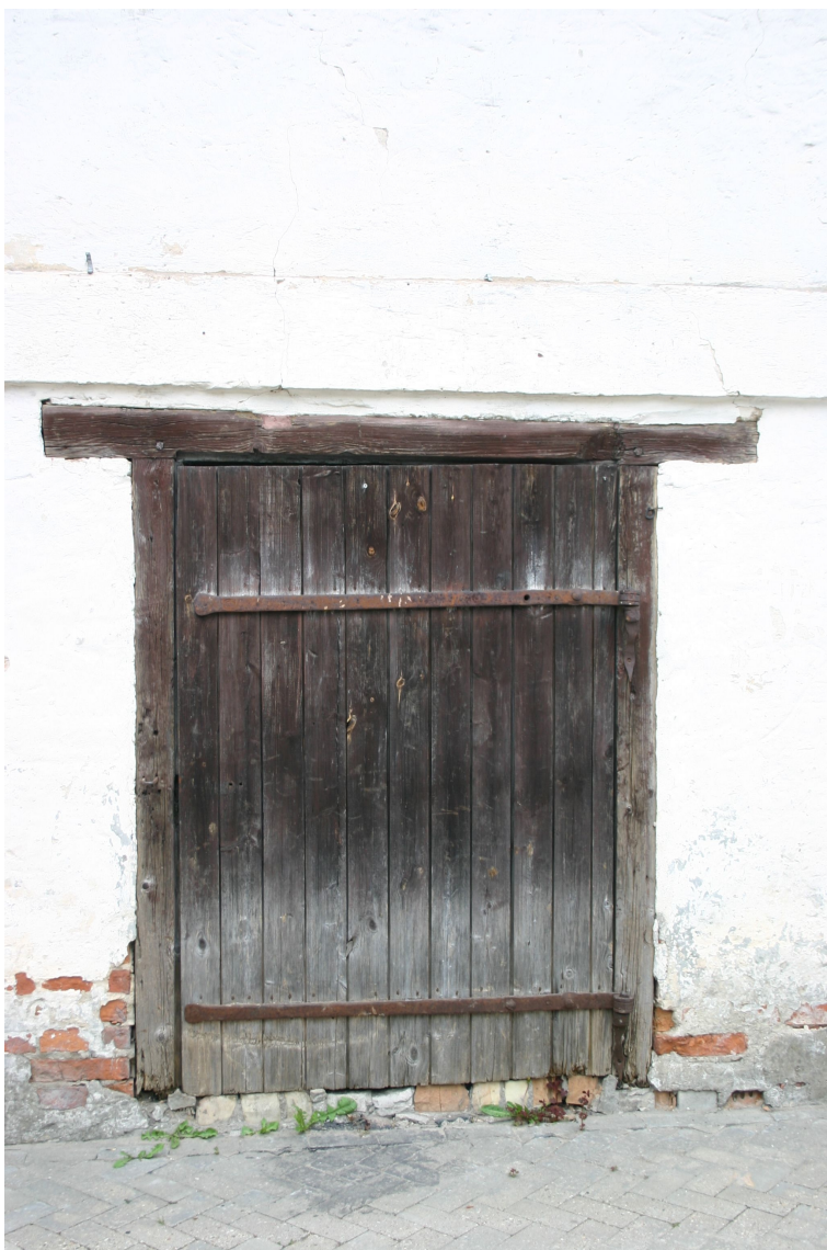
Pasta_5a_62010220046002_durvis1 Sākotnēja (1839.-1870to gadu sāk.) durvju aploda. 20.gs.2.puses vērtņēm izmantotas vēsturiskas viras.
