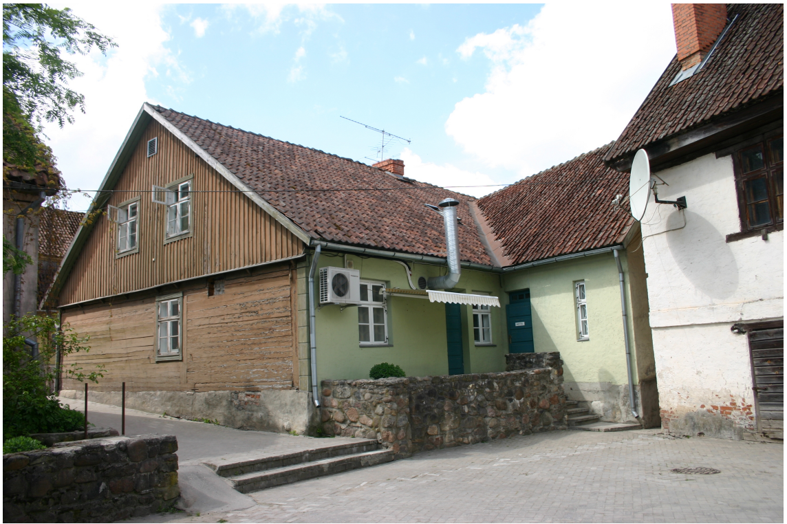
Pasta_5_62010220046001_fasade3 Skats uz ēku no austrumiem.
