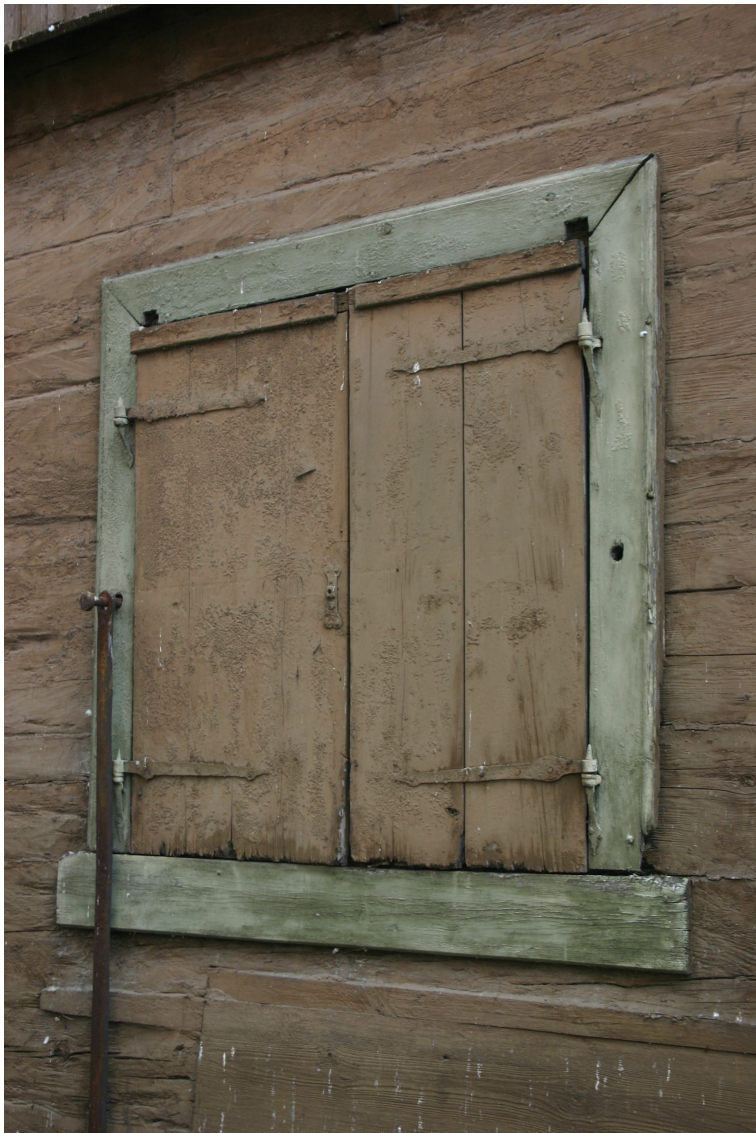
Pasta_5_62010220046001_slegi1 Sākotnējie (18.gs.2.p.) slēgi ar oriģinālo aprīkojumu un apmales. Slēgi apzāģēti, palodze sekundāra.
