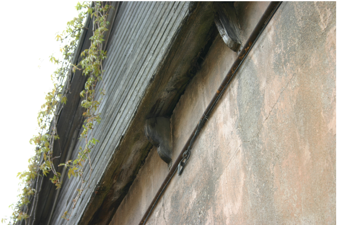
Pasta_3_62010220037001_detala1 Vēsturisks ūdensdēlis un to balstošās konsoles.
