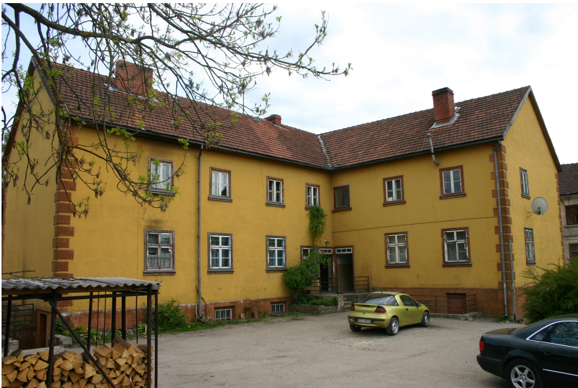
Pasta_1_62010220081001_fasade3 Skats uz ēku no ziemeļiem.
