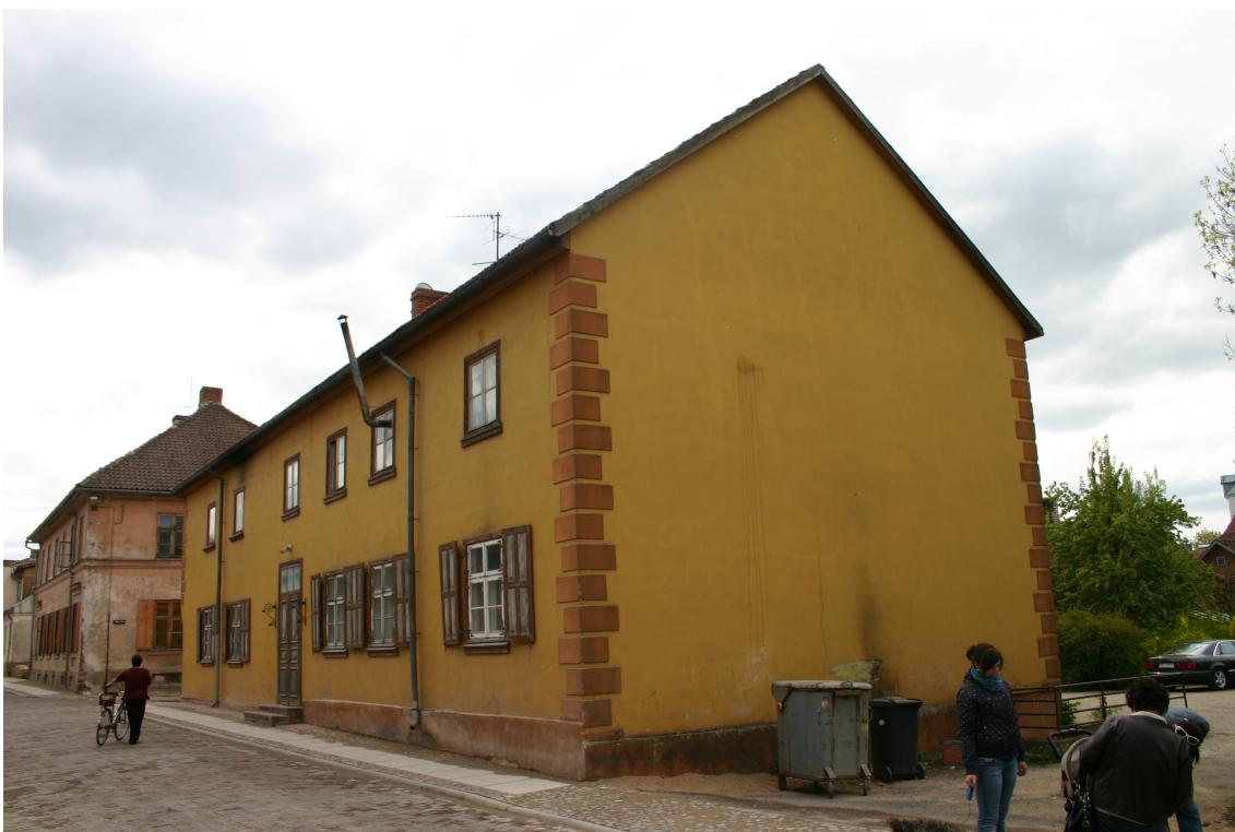
Pasta_1_62010220081001_fasade4 Skats uz ēku no austrumiem.
