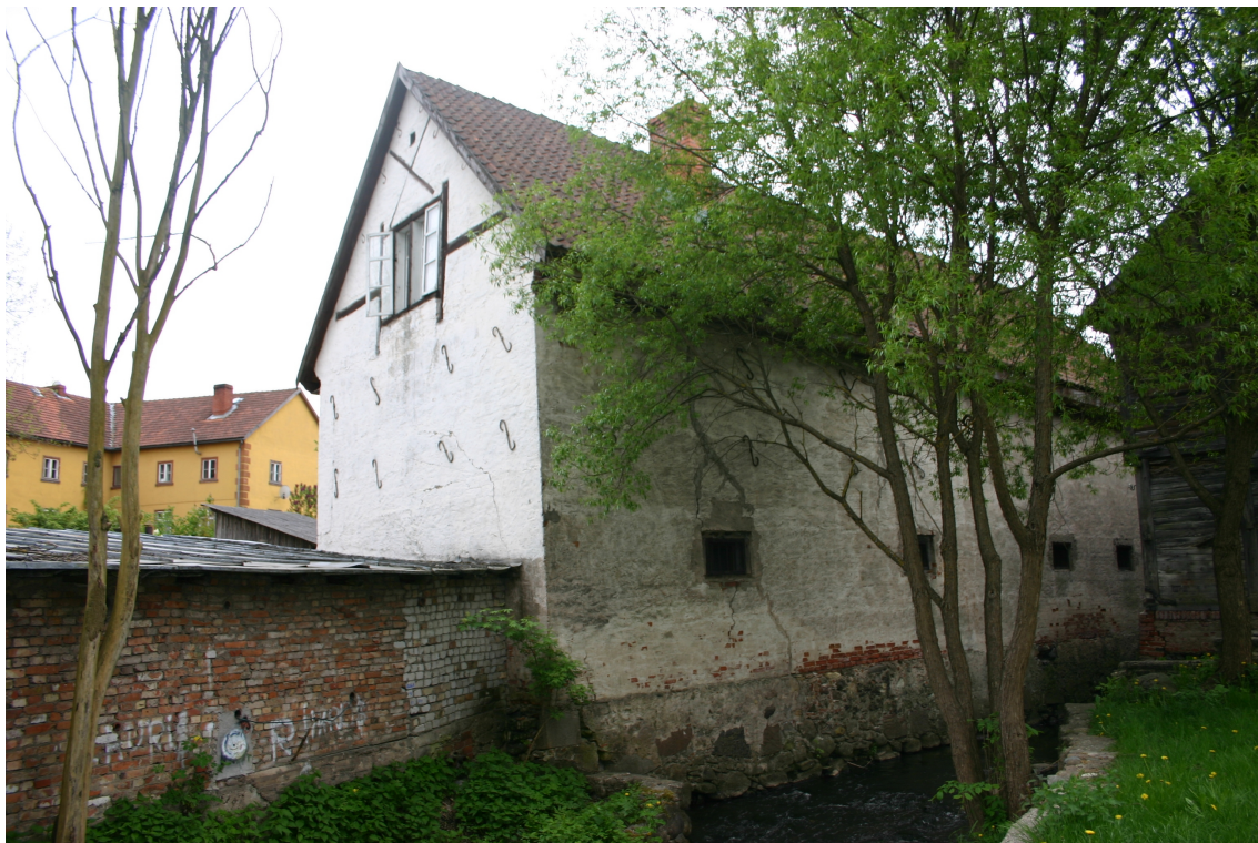
Pasta_5a_62010220046002_fasade3 Skats uz ēku no ziemeļiem.
