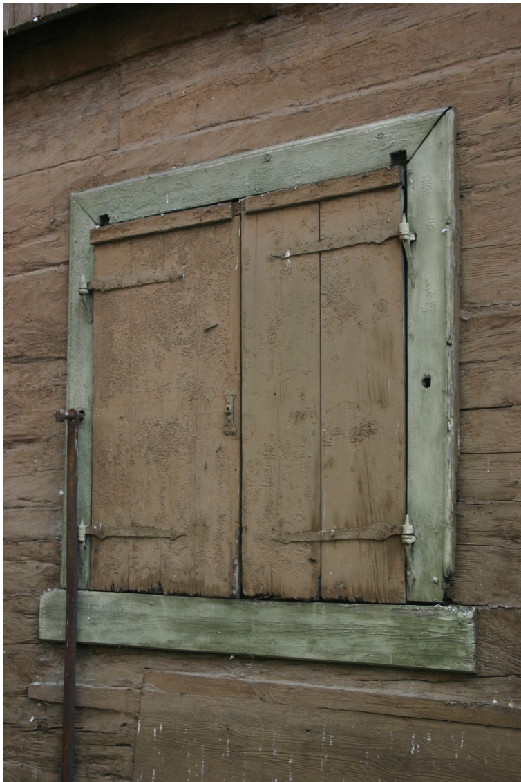
Pasta_5_62010220046001_slegi1 Sākotnējie (18.gs.2.p.) slēģi ar oriģinālo aprīkojumu un apmales. Slēģi apzāģēti, palodze sekundāra.
