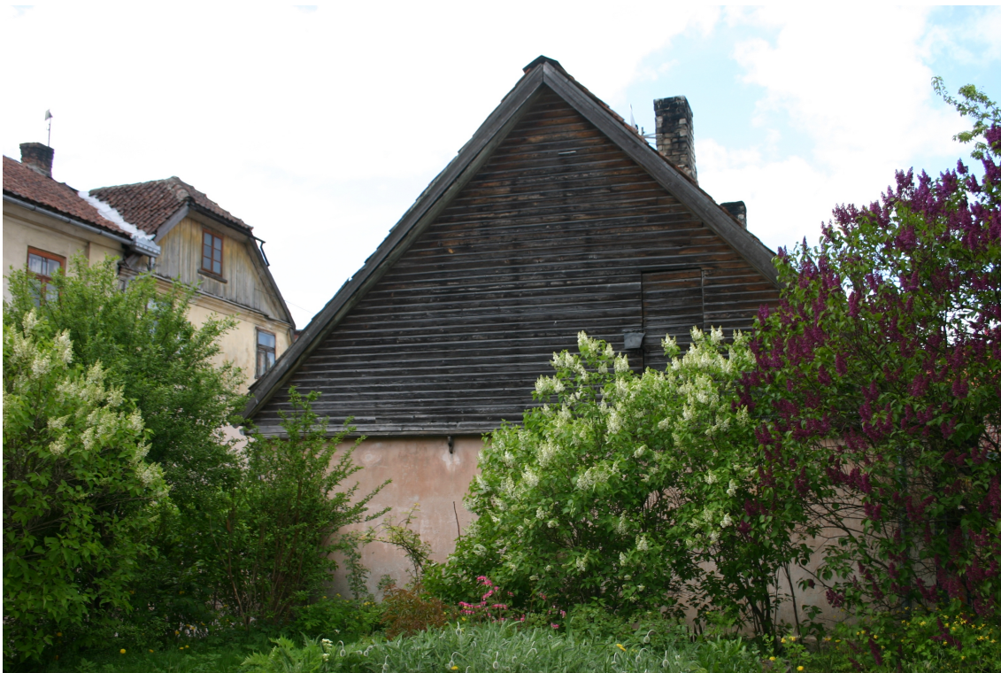
Pasta_3_62010220037001_fasade3 Skats uz ēkas dienvidaustrumu fasādi.
