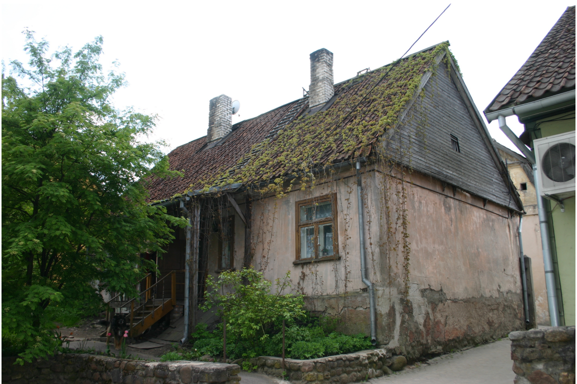
Pasta_3_62010220037001_fasade2 Skats uz ēku no ziemeļiem.
