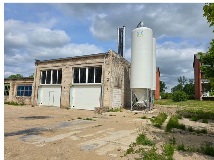
Pirmā apkures sezona Alsungā aizvadīta veiksmīgi, un “Kuldīgas siltumtīkli” saņēmuši pozitīvas atsauksmes no iedzīvotājiem. Šovasar vēl veic teritorijas labiekārtošanu.
