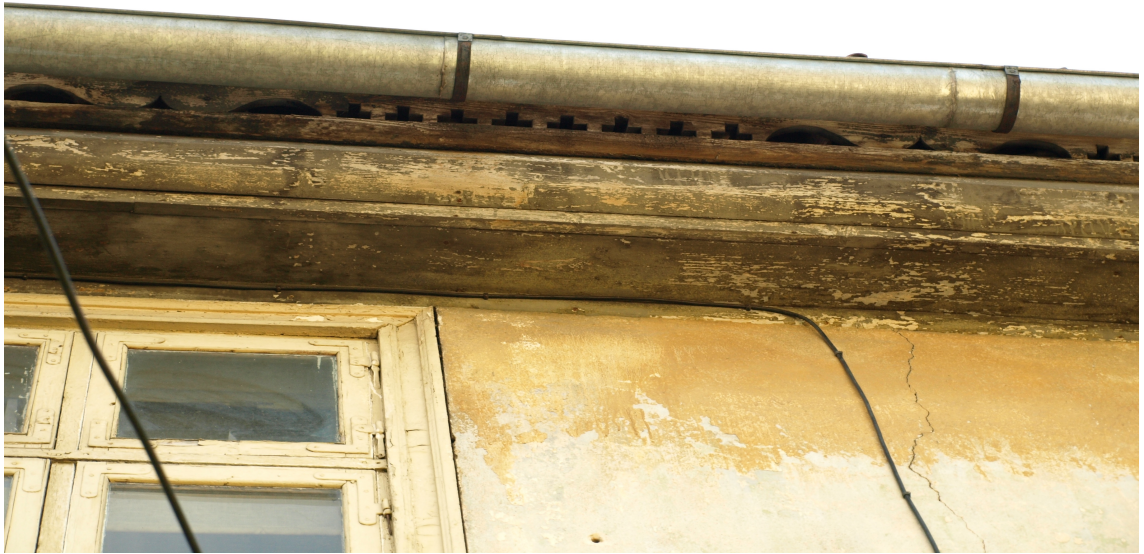
Mucenieku_1_62010230050001_002_dzega2 20.gs.sāk. dēļu dzega un kokā griezts aizsegdēlis.
