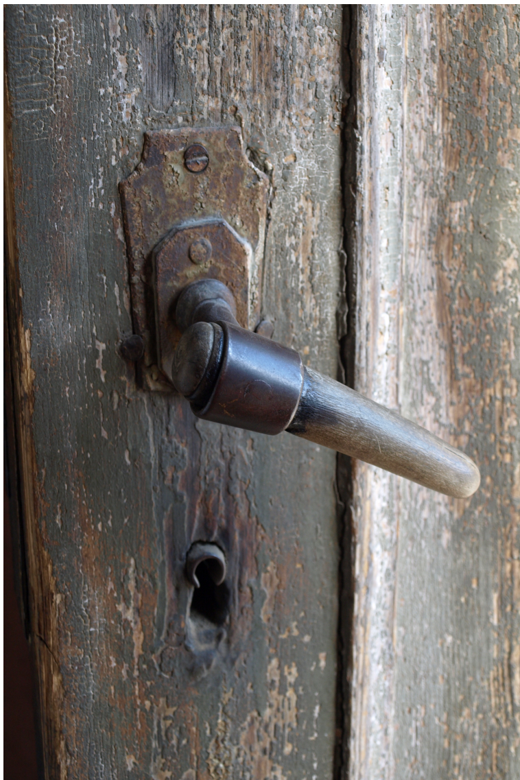
Muceniku_1_62010230050001_002_durvis2 Sākotnējs (19.gs.3.cet.) durvju aprīkojums.
